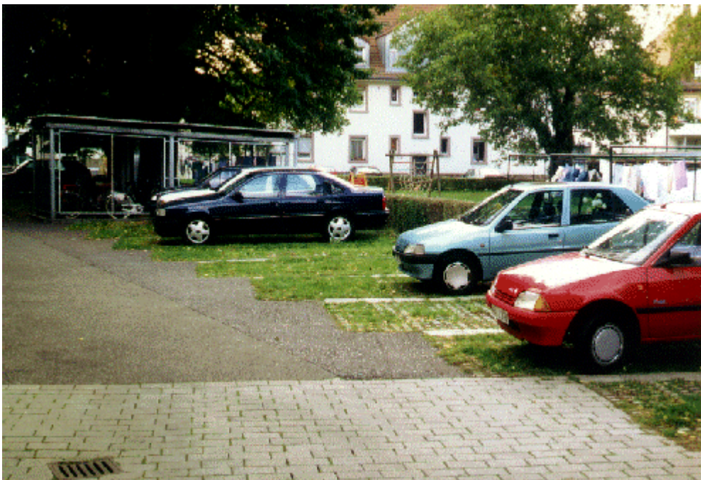
Bild 2: In einem Wohngebiet gelegener Parkplatz mit bereits teilversiegelten Stellplätzen. Belagänderungspotenzial besteht jedoch auf dem Teil Hofes, der nur als Zufahrt zu Stellplätzen genutzt wird.
