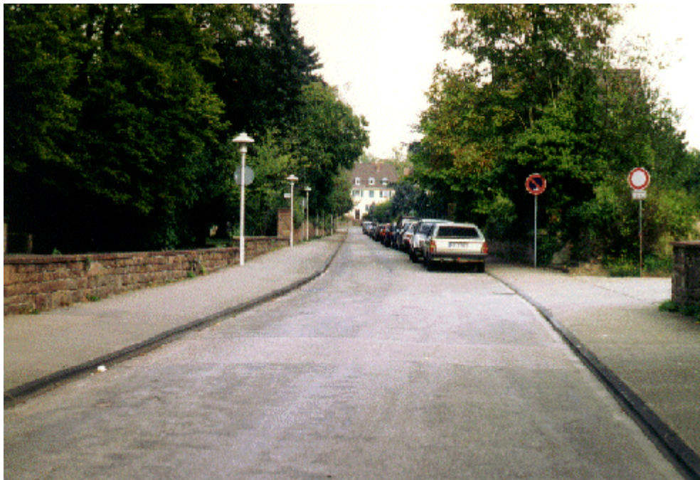
Bild 3: Straße mit Belagänderungspotenzial im Bereich des Parkstreifens
