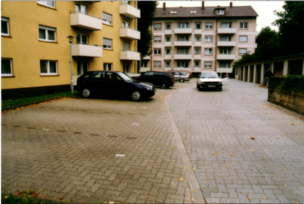
Bild 1: Vollversiegelter, in einem Wohngebiet gelegener Parkplatz mit Belagänderungspotenzial auf den Stellplätzen, vor den Garagen und auf einem großen Teil der Fahrgasse.
