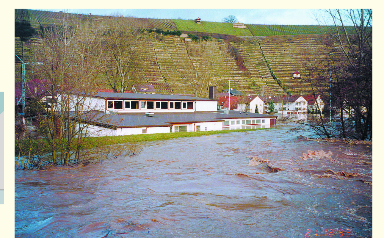
Überströmter Deich in Roßwag an der Enz
