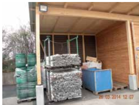
positiv: Korrekte Überdachung für SG 4
