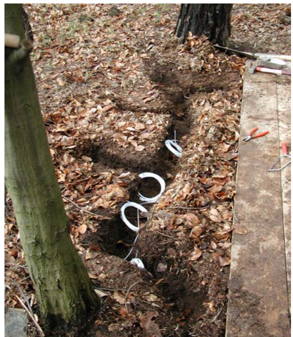
Einbau von Saugkerzen
