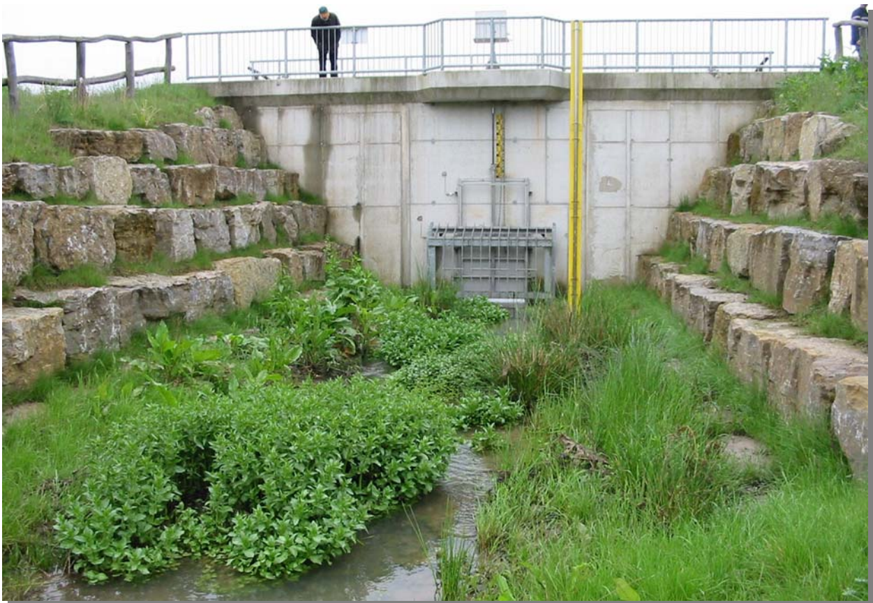
Abb. 51: Stauwand mit Verkleidung aus Natursteinmauerwerk
