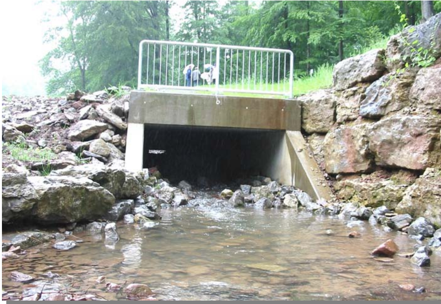
Abb. 53: Rohrdurchlass mit Rechteckquerschnitt
