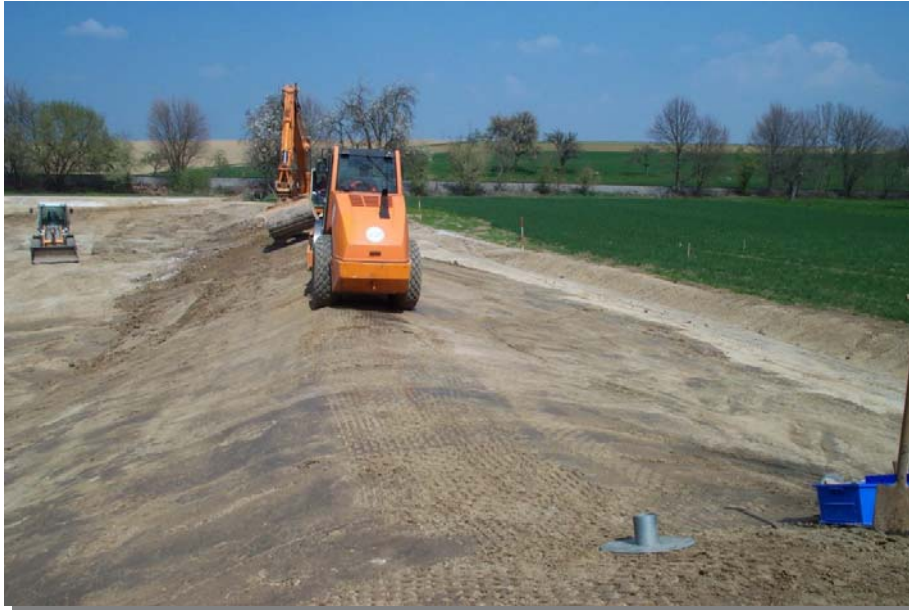
Abb. 27: Überströmbarer Damm aus einer Bodenverfestigung
