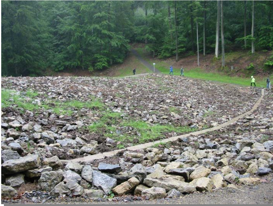
Abb. 2: Deckwerk ausgeführt als Steinschüttung am HRB Haager Tal
