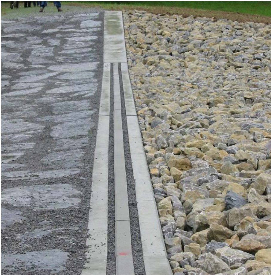
Abb. 46: Ausführungsbeispiel einer in Betonfundamenten versetzten Überlaufschwelle
