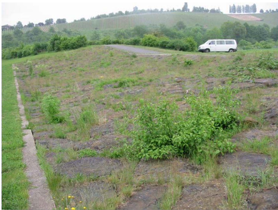
Abb. 1: Deckwerk ausgeführt als Steinsatz am HRB Ellbach
