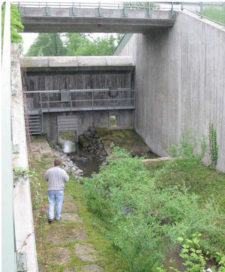
Abb. 55: Stauwand mit zwei Öffnungen
