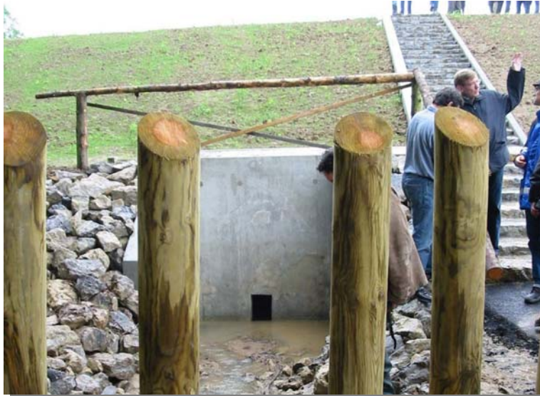
Abb. 54: Rohrdurchlass mit kleiner Einlauföffnung
