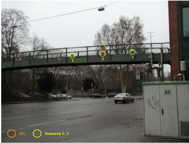
Fahrtrichtung Bad Cannstatt (Fußgängerbrücke)
