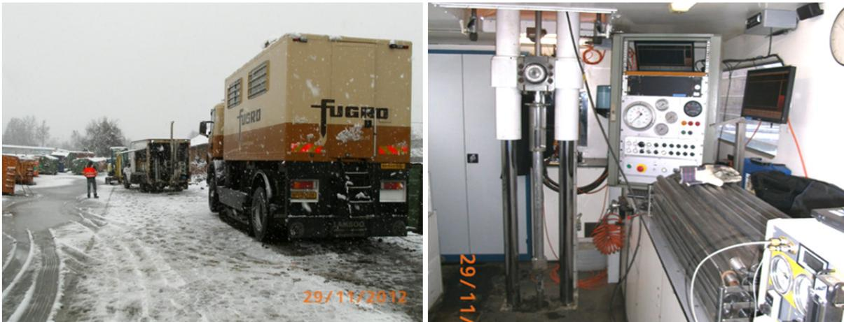
**Abbildung 7-3:** Durchführung der Direct-Push-Sondierungen entlang der Testfeld-Transekte mit Hydraulikstempel für kontinuierlichen CPT- und MIP-Vortrieb
