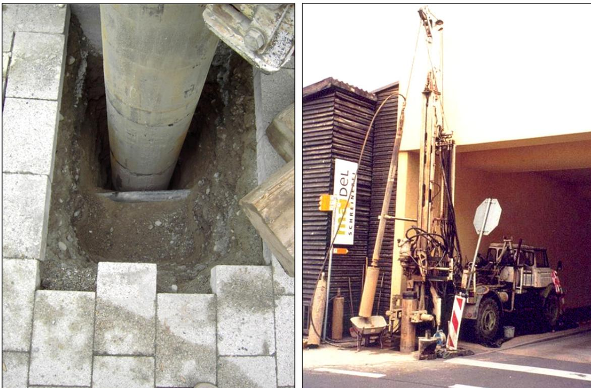
**Abbildung 5-6:** Vorschachtung (rechts) und Bohrarbeiten unter für Innenstadtverhältnisse typischen engen Platzverhältnissen (links)
