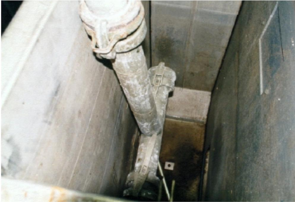
Auslauf des Rohrflockers in das Becken
