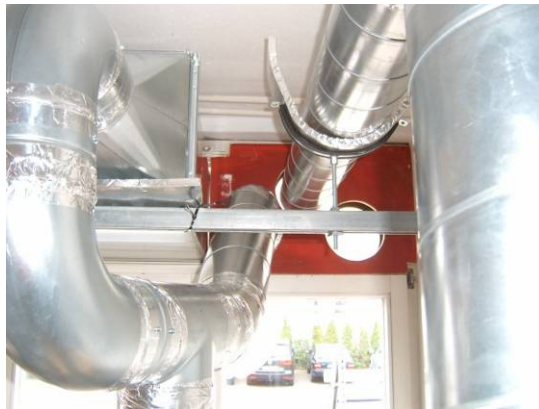
Abbildung 54: Aufbau der Rohreinlässe
