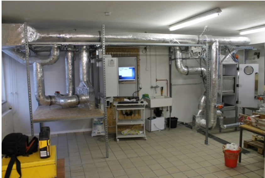
Abbildung 55: Der Teststand nach Fertigstellung
