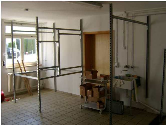
Abbildung 53: Gestell für die Verrohrung im airwasol-Technikum
