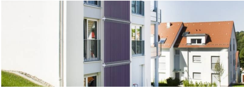
Abbildung 15: Fassadenintegrierter Solarluftkollektor
