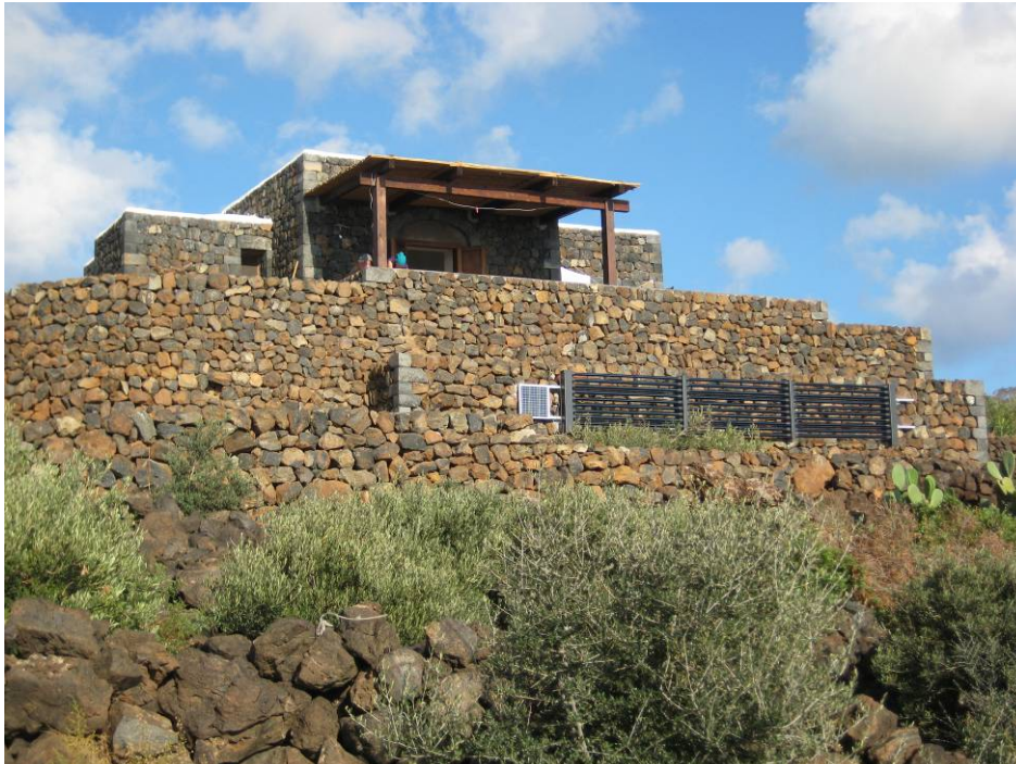
Abbildung 58: Kollektoranlage mit neuem TST-Kollektor der Firma airwasol installiert auf Pantelleria
