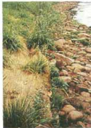
Abb. 41: Austrieb der Röhrichtwalze und Röhrichtballenpflanzung (Aufn.: WBA FDS 1990).
