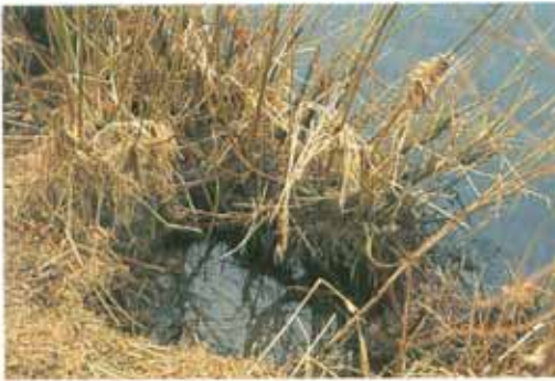
Abb. 36: Erosion hinter der Weidenfaschine (Aufn.: LfU 1996).
