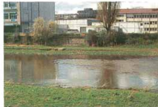
Abb. 51: Schaden am Schotterrasenweg im Bereich des Schachtes (Aufn.: LfU 1994).
