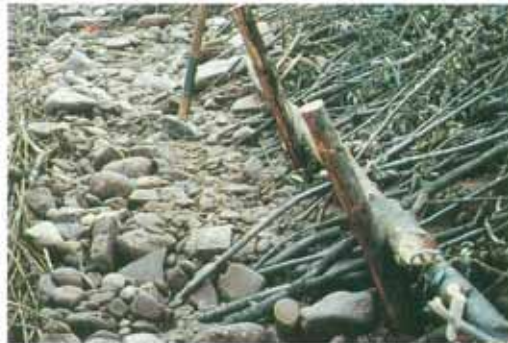
Abb. 38: Faschinenwalze mit anschließender Spreitlage (Aufn.: WBA FDS 1990).
