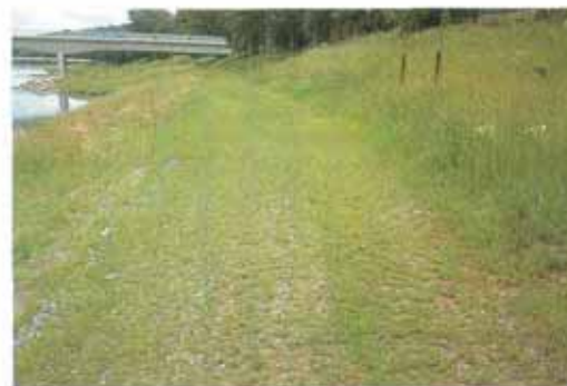
Abb. 50: Schotterrasenweg leicht begrünt (Aufn.: LfU 1991).
