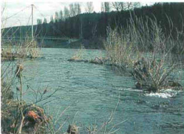
Abb. 58: Uferschäden bei km 57+100 (Aufn.: Universität Karlsruhe 1994).
