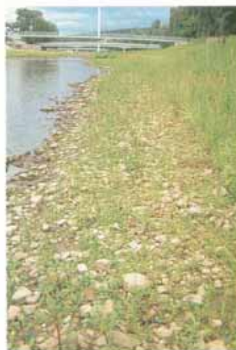
Abb. 7: Mittelwasserlinie aus vorhandenem Sohlsubstrat (Aufn.: LfU 1991).
