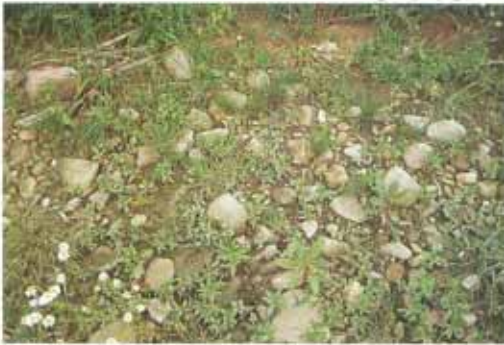
Abb. 43: Rollierung aus vorhandenem Sohlsubstrat (Aufn.: LfU 1991).
