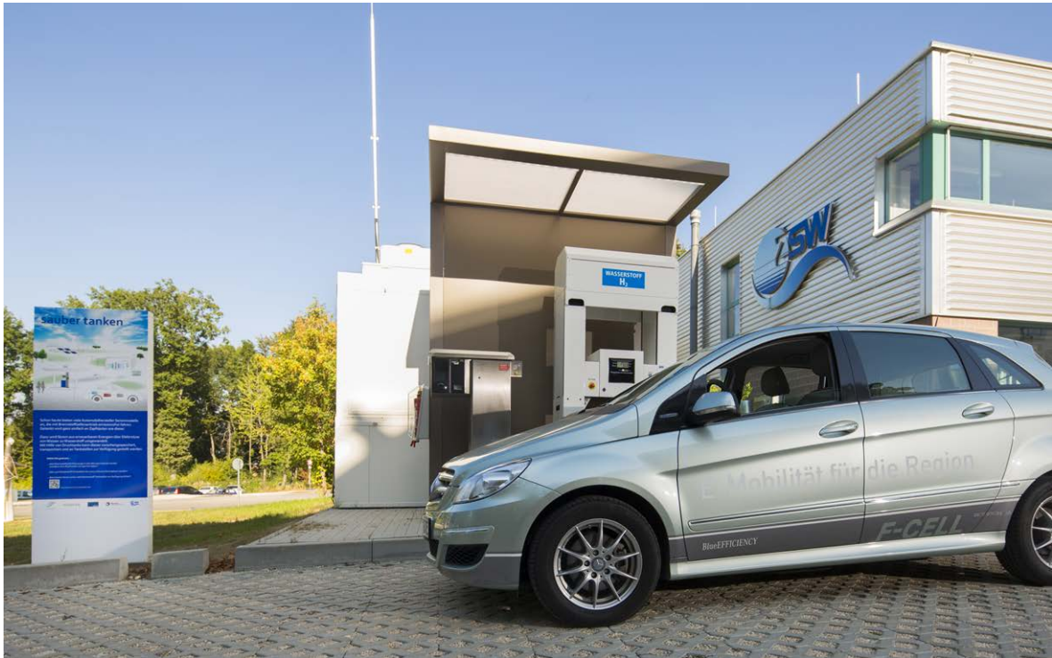
Abbildung 7: Ulmer Wasserstofftankstelle am ZSW mit Brennstoffzellen-Fahrzeug Daimler FCell
