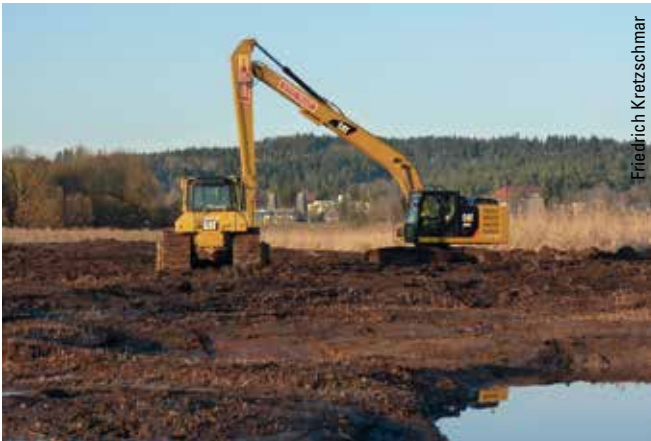
Abbildung 2: Zum Ausbaggern und zur Feingestaltung der Uferlinie wurde ein Langarm-Bagger (18 m Reichweite) genutzt, zur Verteilung des Materials auf der Fläche eine Spezialraupe (Moorfahrwerk und 85 cm breite Ketten).
