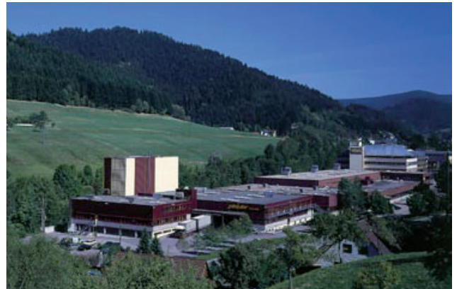
Ansicht der Fa. Grieshaber in Schiltach
