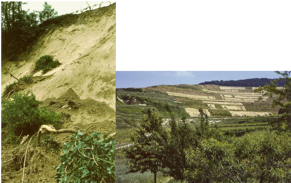
Abbildung 4-24: links: Böschungsrutschung im Kaiserstuhl, rechts: großflächige Schäden im Gewann Herrenstück bei Bickensohl, Fotos aus WILMANN (2011)
