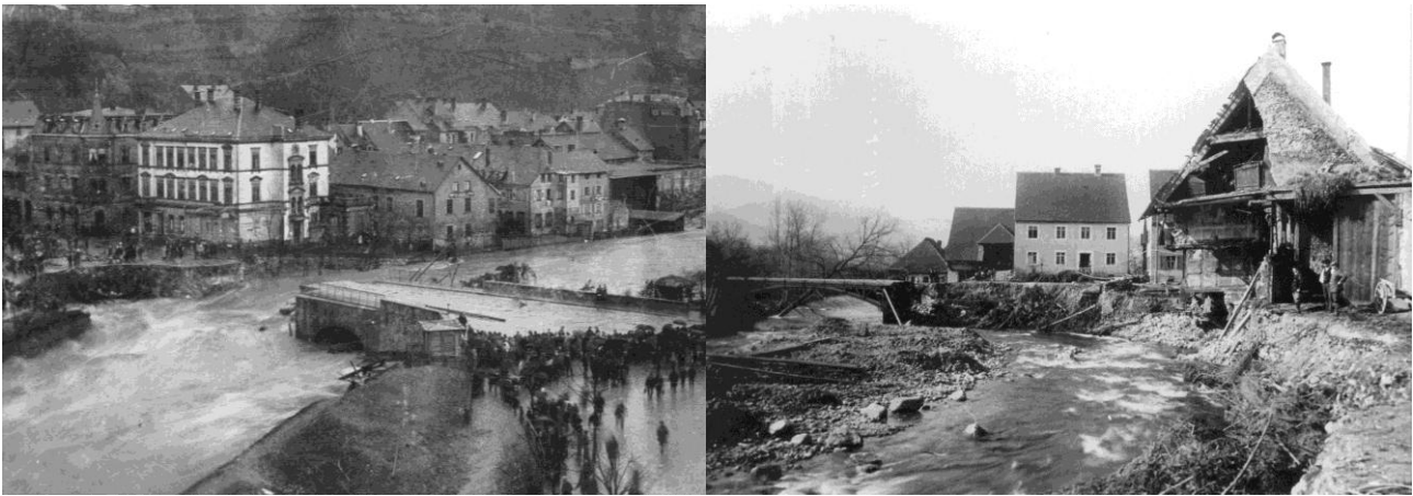
Abbildung 4-28: Schäden in Freiburg (Schwabentorbrücke) und in Zarten bei einem Hochwasserereignis der Dreisam im Jahr 1896 (aus: LANGE 2007)
