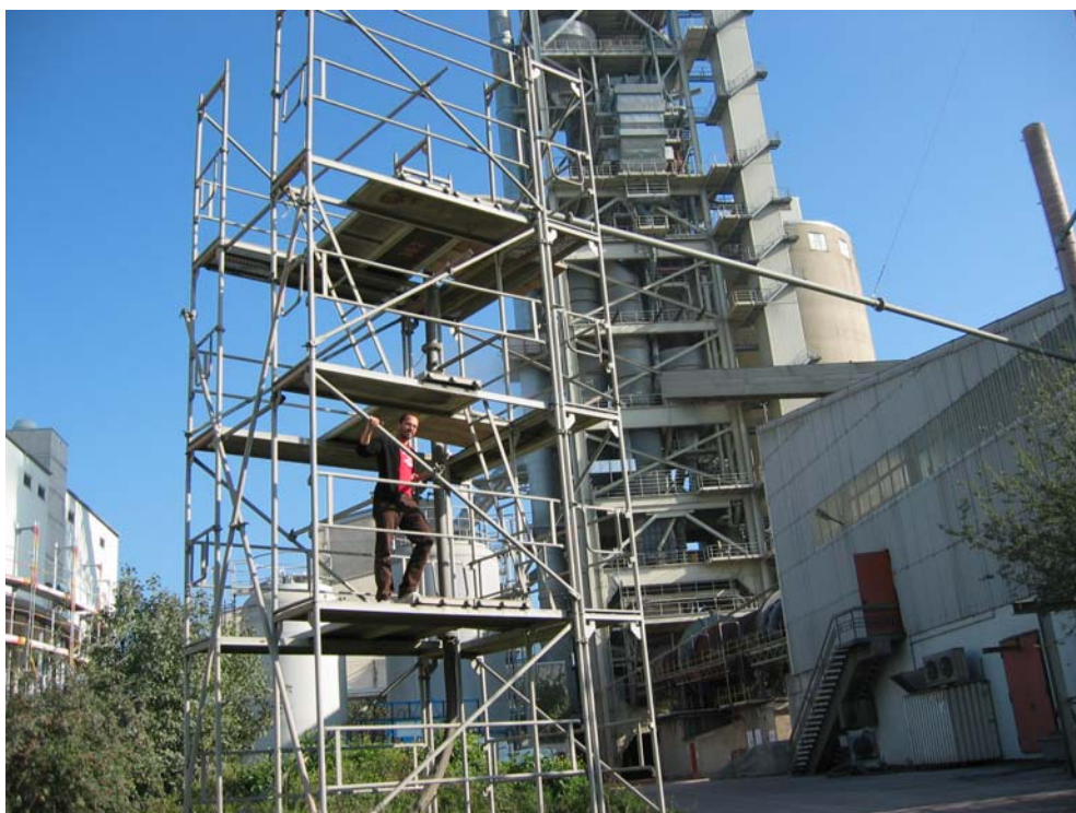
Abb. 22: Verlauf der Blasleitung zum Drehrohrföfen
