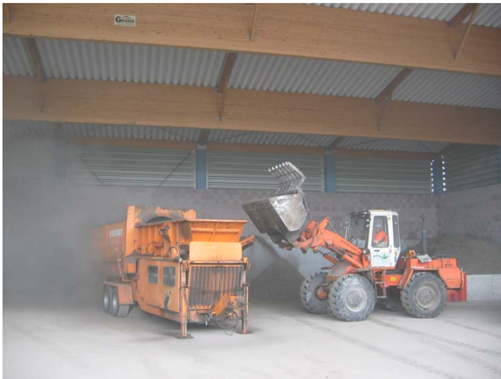
Abb. 17: Siebung des getrockneten Mix mit einem Trommelsieb (30 mm)
