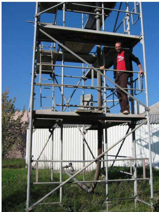
Abb. 21: Rückseite der Andockstelle mit Blasleitung
