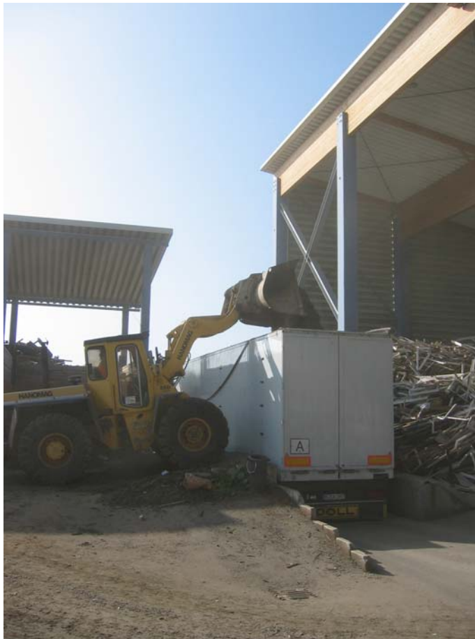
Abb. 18: Befüllung des Walking Floor LKW mit dem getrockneten Mix
