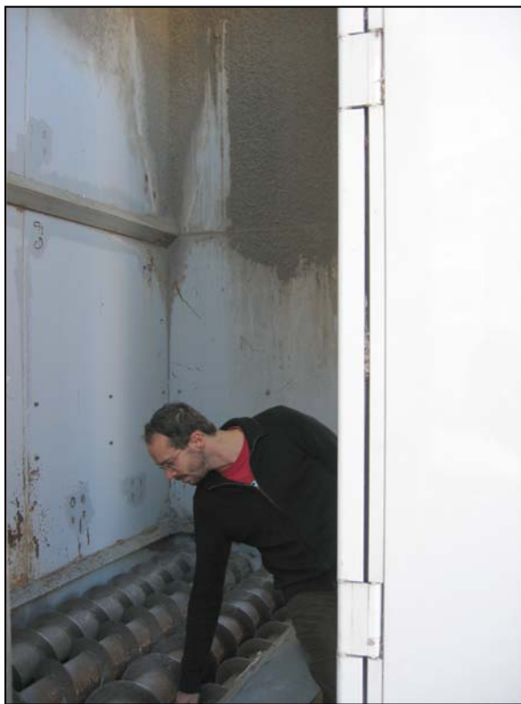
Abb. 19: LKW, kurz vor Andocken an die Schneckenförderer der Einblasstation
