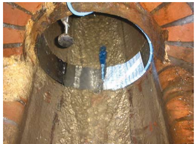
Abb. 15: Kombierter Messwertaufnehmer nach dem Ultraschall-Doppler-Prinzip
