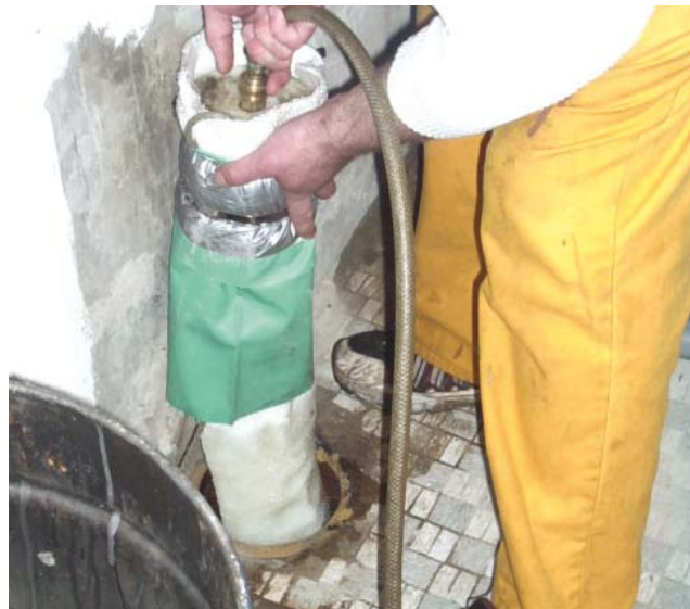
Abb. 72: Inlinersanierung über Revisionsöffnungen in Falleitung (links); Inlinersanierung über Ablauf eines demontierten Fallrohrs (rechts)
