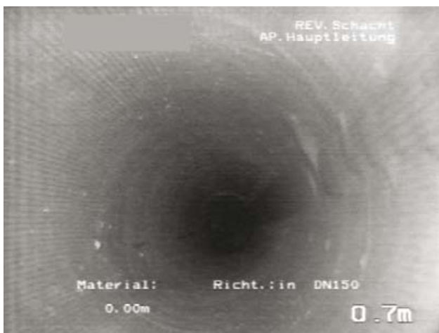
Abb. 74: Mit Schlauchliner sanierter Hauptleitungsstrang
