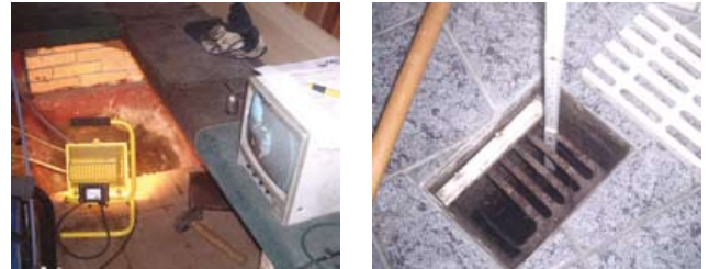
Abb. 64: Wasserfüllstandsprüfung nach DIN 1986, Teil 30; Abspernung der seitlichen Leitung unter Kamerabeobachtung (links), Messung des Wasserstandes im Bodenablauf (rechts)
