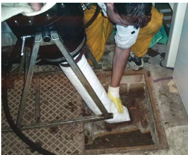
Abb. 70: Schlauchlinersanierung über einen Revisionsschacht innerhalb eines Hauses: Inversion des Inliners (links), Freischneiden des Liners (rechts)
