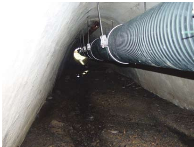
Abb. 82: Rohr-in-Rohr-Lösung zur Ableitung von Fremdwasser (links abgehängte Fremdwasserleitung in Göppingen, rechts Sohlleitung zur Ableitung eines Baches im Mischwassersammler in Freiberg/Sachsen (Bild: Kovacic Ingenieure GmbH, Sigmaringen)
