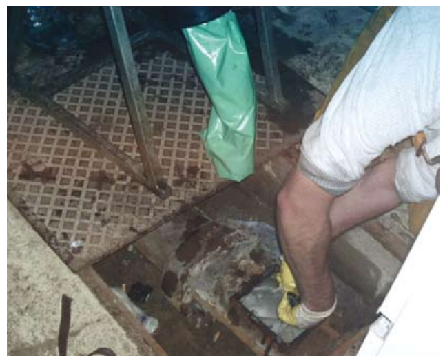
Abb. 70: Schlauchlinersanierung über einen Revisionsschacht innerhalb eines Hauses: Inversion des Inliners (links), Freischneiden des Liners (rechts)
