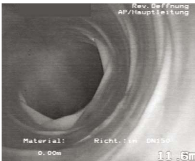
Abb. 76: Faltenbildung im Bogenbereich
