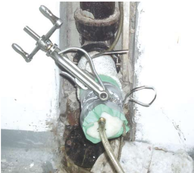
Abb. 72: Inlinersanierung über Revisionsöffnungen in Falleitung (links); Inlinersanierung über Ablauf eines demontierten Fallrohrs (rechts)
