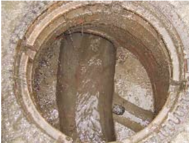
Abb. 14: Klarer Abfluss - Ein mögliches Indiz für Fremdwasser
