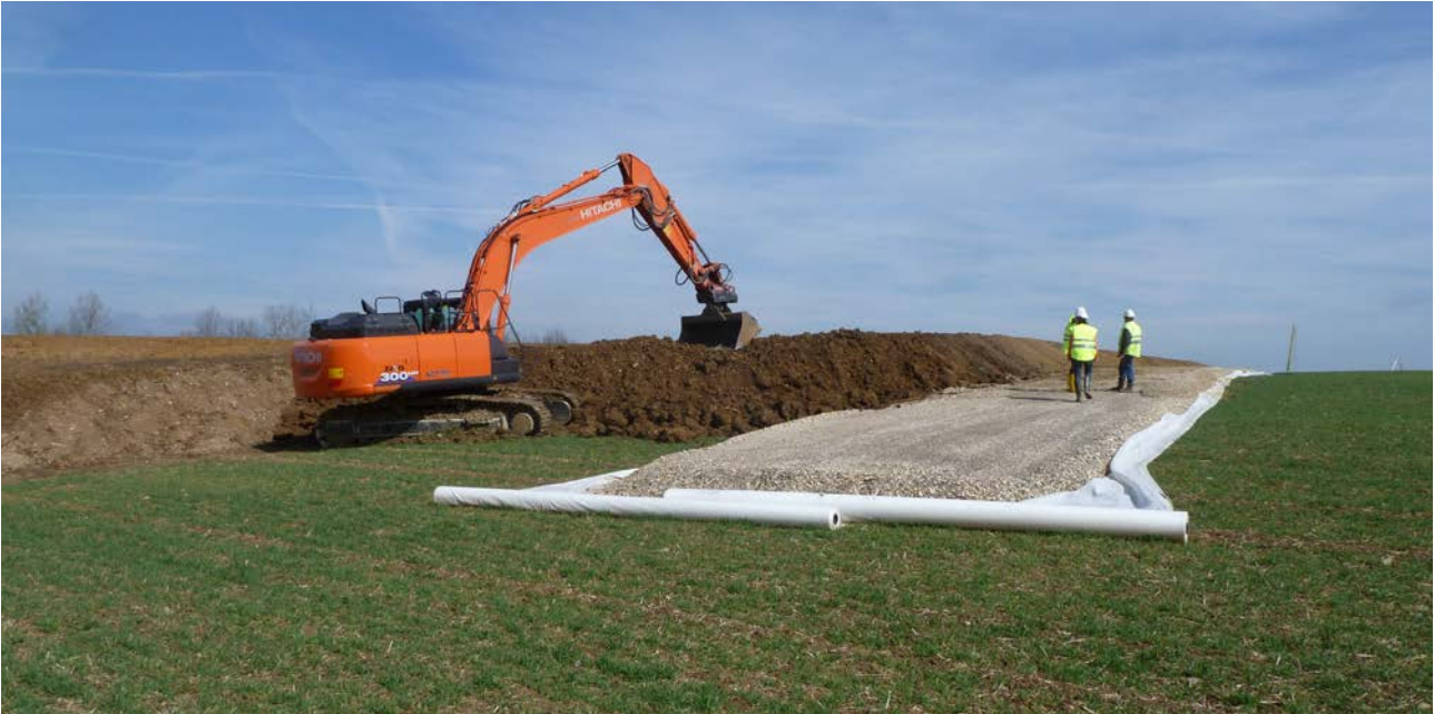
Abbildung 4.1: Fachlich korrektes Erstellen der Oberbodenmiete mit Baustraße zur Anlieferung
