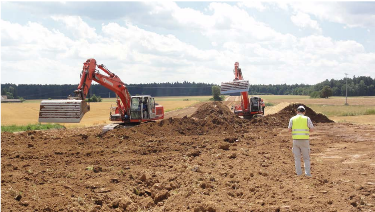
Abbildung 1.2: Bodenauftrag mit bodenkundlicher Baubegleitung
