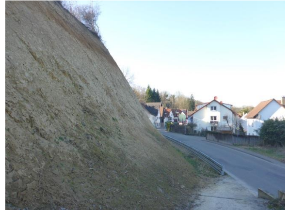
Abbildung 18: Hangbefestigung nach einem Erdbeben am Tuniberg. (H. Sharaf)
