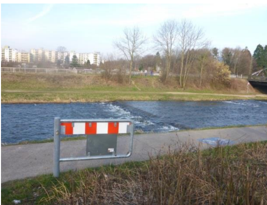
Abbildung 20: Schranke am Dreisamuferweg, welche sich bei Hochwasser automatisch schließt. (H. Sharaf)
