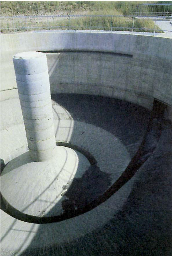
Offenes Regenzyklonbecken mit strömungsbedingter Mittelstütze und außenanliegendem Klärüberlauf (Drosselschlitz)
