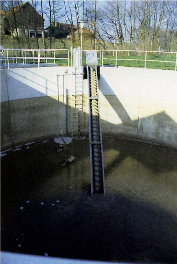
Wirbelschachtbecken mit mittig angeordneter Rohrschnecke zur Entleerung
