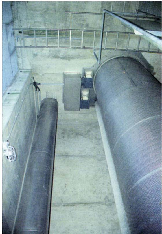
Drehtrommelfilter mit Notüberlaufschwelle und Spülkippe zur Räumung des Siegutes nach Beckenentleerung
