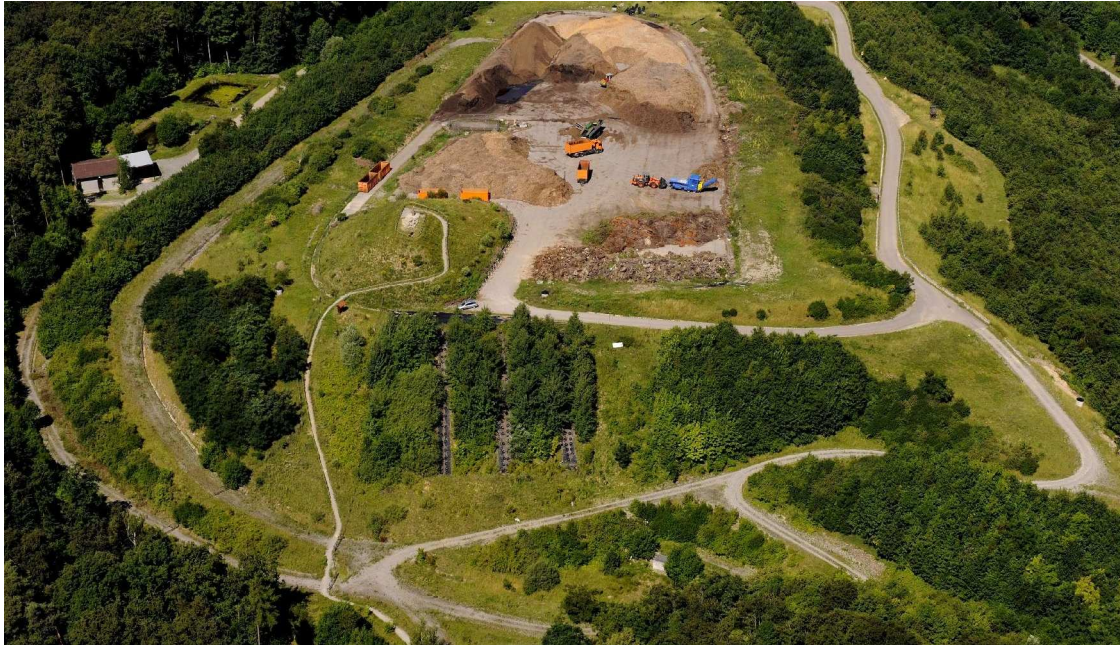
Bild 1: Die Versuchsanlage auf der Kreismülldeponie Leonberg
