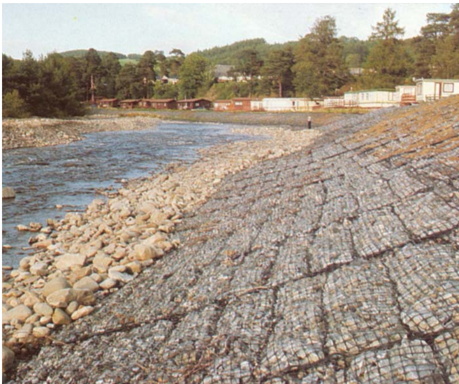
Abb. 26: Gabionen aus Geogittern als Ufersicherung
