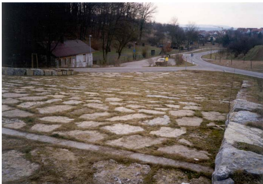
Abb. 9: HRB Kohlbach mit Deckwerk als Steinsatz und Querriegeln
