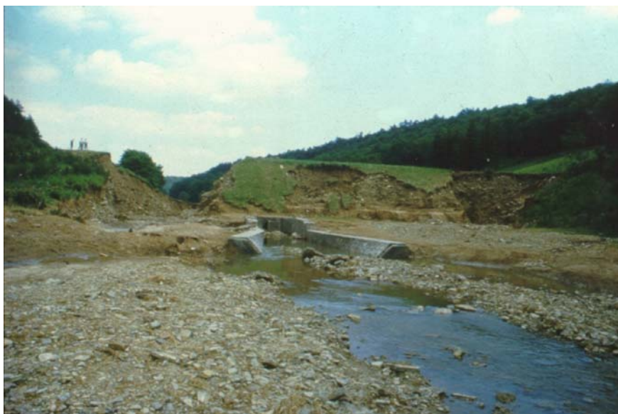
Abb. 3: Dambruch bei Gissigheim im Juni 1984
