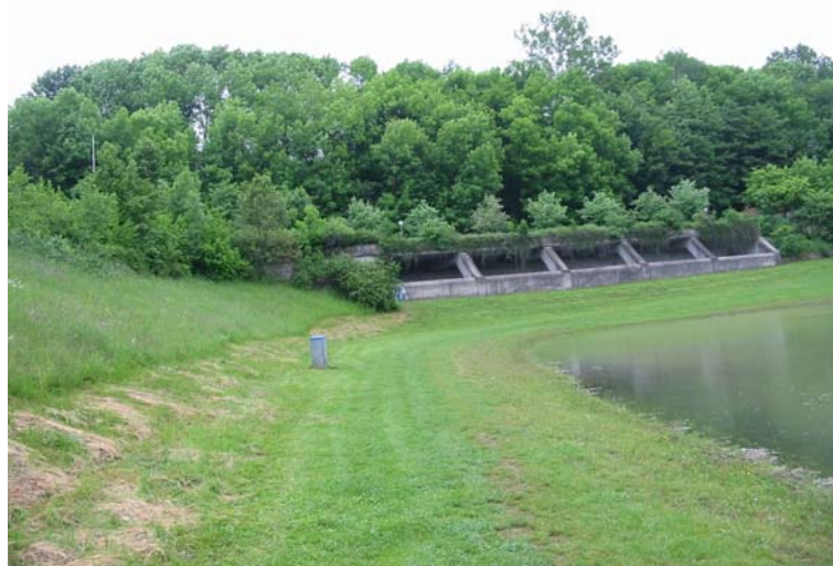
Abb. 1: Hochwasserentlastungsanlage ausgeführt als Hangseitenentlastung
