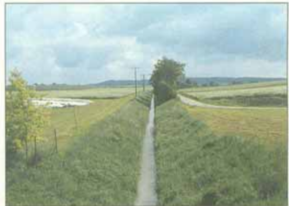
Abb. 52: Brettach (Landkreis Schwäbisch Hall). Oberlauf der Brettach im Bereich des Lettenkeupers. Die Linienführung ist extrem verändert, die Ufer- und Sohlbereiche sind technisch gesichert, die intensive Landnutzung findet bis in unmittelbarer Gewässernähe statt, uferbegleitende Gehölzsäume sind nicht existent, Drainageeinrichtungen sind vorhanden. Bewertung des Abschnitts: Naturfern.
