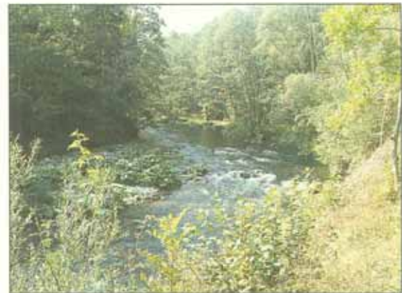
Abb. 58: Wutach (Landkreis Waldshut). Weitgehend unveränderte Linienführung, üppiger Gehölzsaum uferbegleitend, überwiegend Misch- und Laubwald angrenzend, reiche Strukturvielfalt im Gewässerbett, nahezu keine landwirtschaftliche Nutzung in diesem Abschnitt, spärliche Verkehrserschließung in diesem relativ engen Talabschnitt in Muschelkalk-Schichten. Bewertung des Gewässerabschnitts: Weitgehend naturnah.
