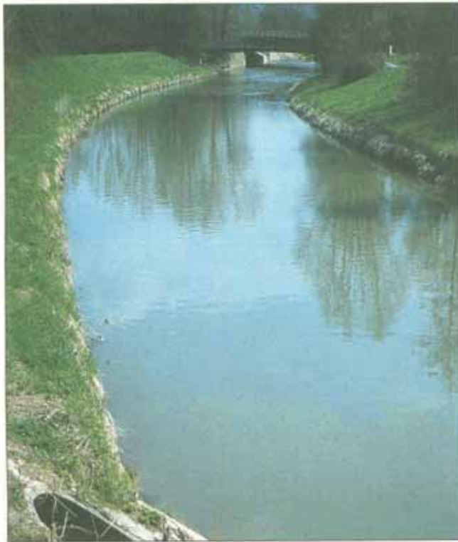
Abb. 36: Rems bei Großheppach (Rems-Murr-Kreis). Gewässerstrecke I. Ordnung mit starker Veränderung der Linienführung, keinem ufernahen Gehölzsaum, technisch gesicherte Uferböschungen, intensiv genutztem Umfeld, künstliche Wanderungshindernisse. Bewertung des Abschnitts: Naturfern.
