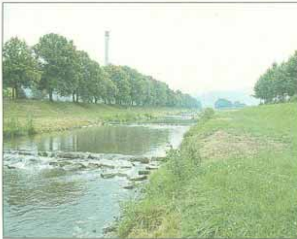
Abb. 8: Rench bei Oberkirch (Ortenaukreis). Gewässerstrecke I. Ordnung, Umgestaltung in der Phase der Acher-Rench-Korrektion der 30er-Jahre. Ausgestaltung mit Doppeltrapezprofil, Schwellen bzw. künstlichen Wanderungshindernissen. Umgebung i.d.R. intensiv genutzt (Siedlungen, Landwirtschaft, Verkehrsinfrastruktur etc.).
