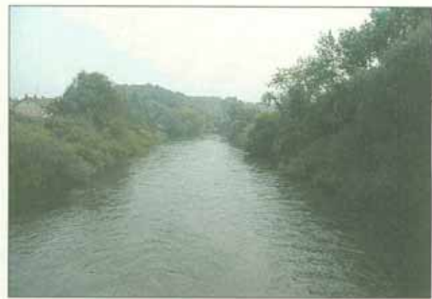
Abb. 27: Donau bei Untermarchtal (Alb-Donau-Kreis). Weitgehend unveränderte Linienführung, intakter Gehölzsaum, unterschiedliche Talbodennutzung, wenige künstliche Wanderungshindernisse. Bewertung: Weitgehend naturnah.
