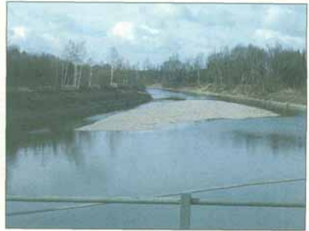
Abb. 74: Iller mit Mooshausener Wehr bei Km 52,8, Nähe Aitrach (Landkreis Ravensburg). Massive Befestigung der Uferpartien, Sohlverbau, zahlreiche Wasserkraftanlagen, begradigte Linienführung, Gehölzsaum mit Abstand zum Ufer angepflanzt, relativ viele Ortschaften gewässerbegleitend . Bewertung: Naturfern .
