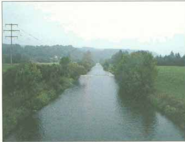
Abb. 35: Wutach im Raum Wutöschingen (Landkreis Waldshut). Gewässerstrecke I. Ordnung mit starker Veränderung der Linienführung (Begradigung), zahlreichen Schwellen, intensiver Nutzung des gewässernahen Umfeldes, fehlendem Ufergehölzsaum (wenige nachgepflanzte Einzelgehölze als Uferbewuchs). Bewertung des Abschnitts: Naturfern.
