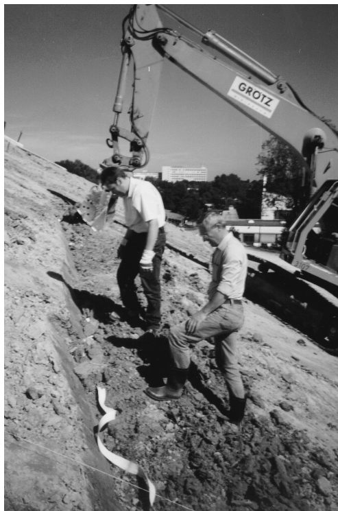
Bild 5: Entspannte Verlegung des Kabels in der Baggerfurche
