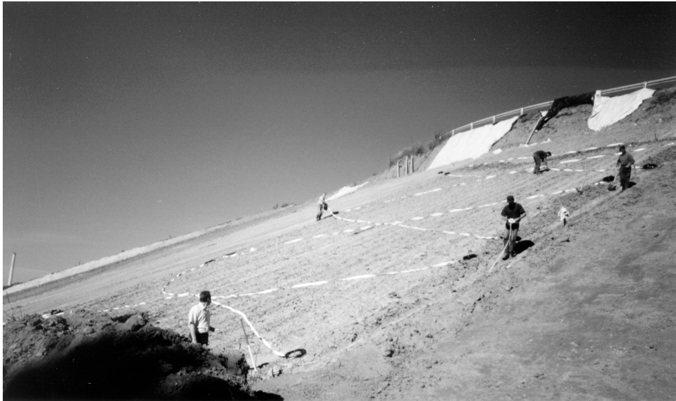
Bild 4: Kreuzweise Verlegung der Meßkabel auf der Deponie Karlsruhe-West
