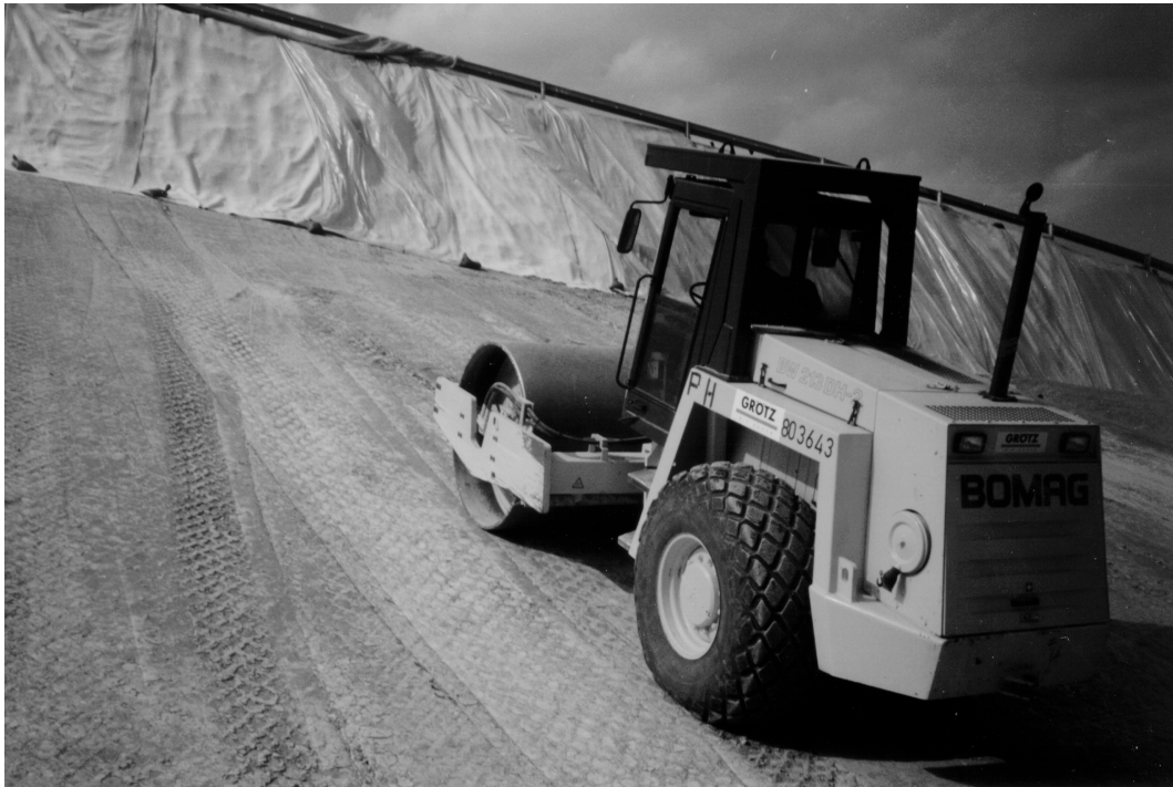
Bild 6: Wiederverdichtung nach dem Kabelverlegen
