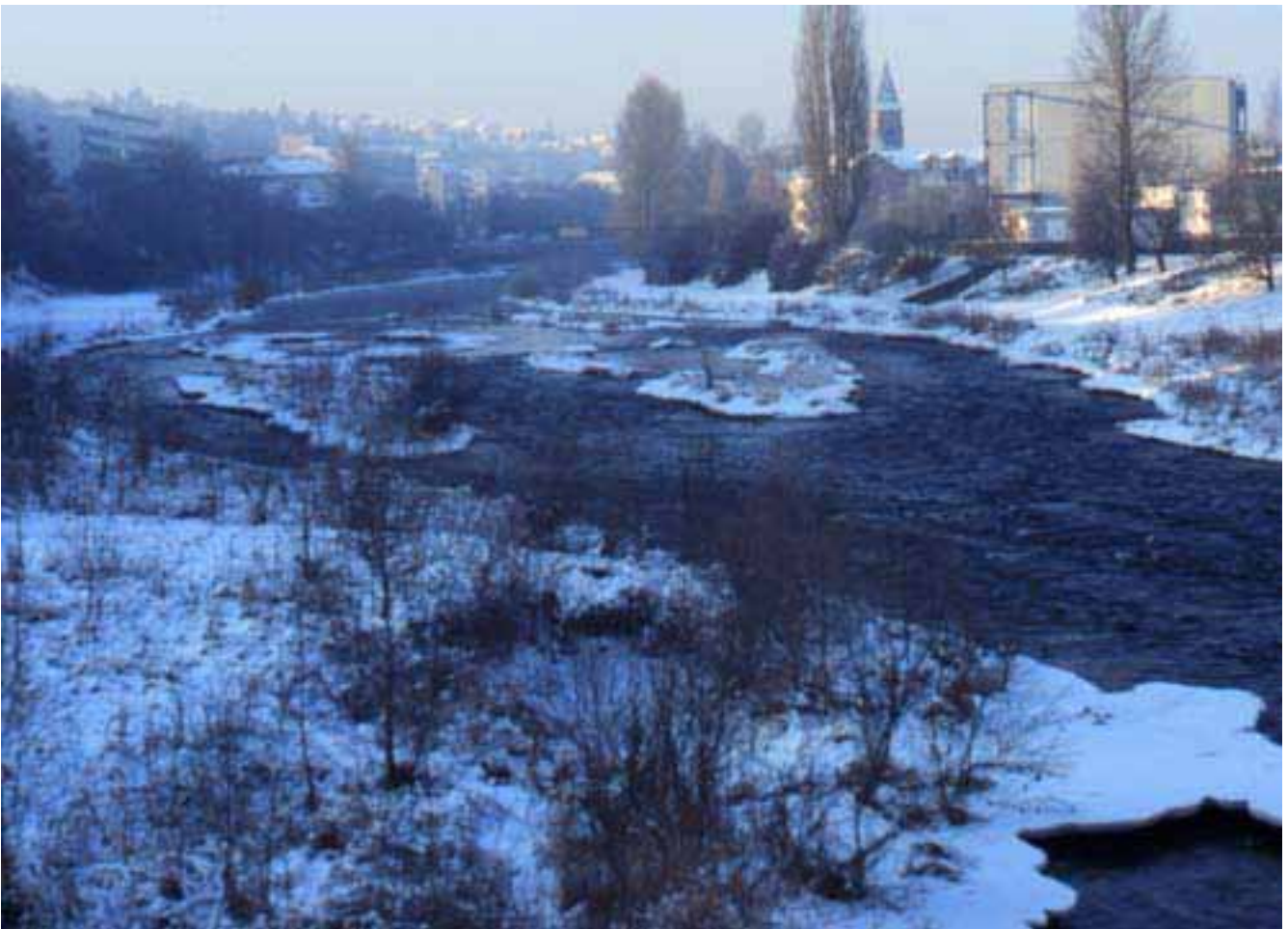
Abb. 1.6: Aufweitung des Flussschlauches durch eingebaute Inseln bei der renaturierten Gewässerstrecke in der Ortslage Pforzheim (Enz) bei Mittelwasserabfluss. Welchen Einfluss haben die Inselstrukturen bei Hochwasser und wie wird dadurch die Abflussleistung beeinträchtigt? Ansätze zur hydraulischen Berechnung werden im Leitfaden Teil 1 und Teil 2 gegeben.
