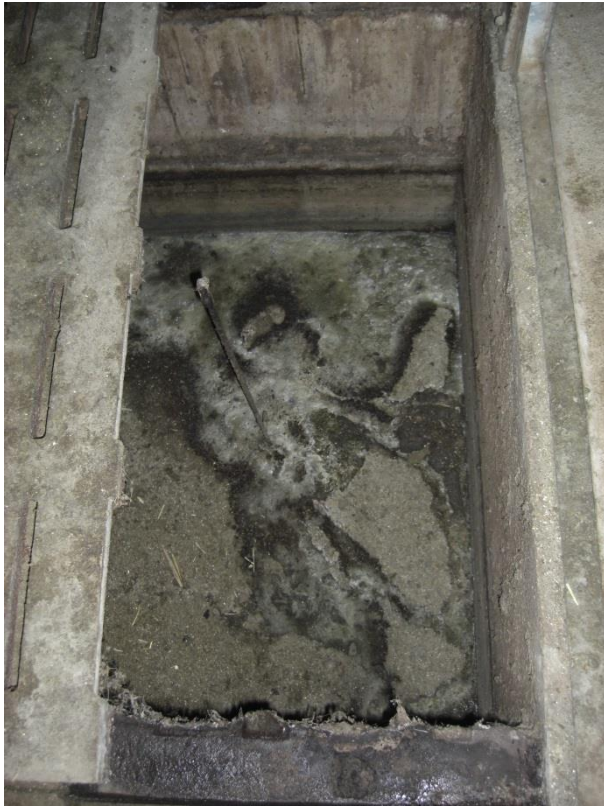
Abbildung 58: Geöffneter Spaltenboden mit Stöpsel zum Ablassen der Gülle
