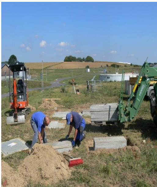
Abbildung 28: Fundamentlegung Container
