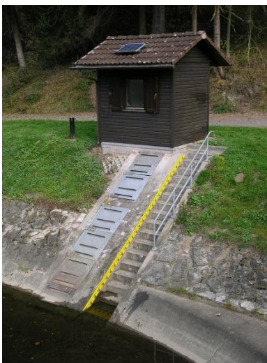
Bild 9: Horgen-Eschach 2008-10-15 Treppe und Schacht
