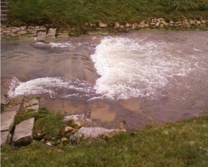
Bild 16: Tuttlingen-Elta 2013-11-21 Handlungsbedarf durch Kolkbildung
