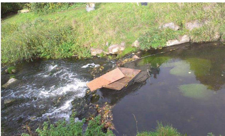
Bild 12: Ubstadt-Kraichbach 2012-10-18 Ablagerungen auf der Pegelschwelle
