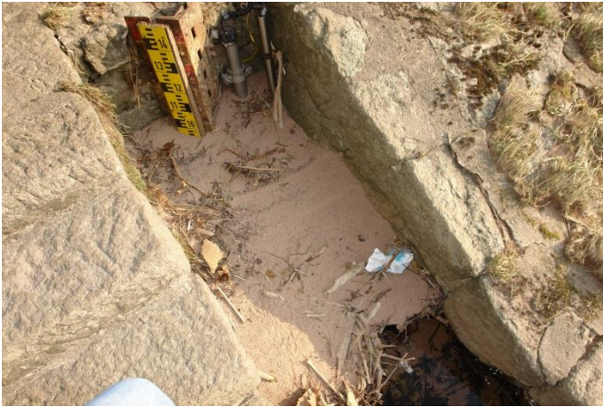
Bild 13: Wolfach-Kinzig 2012-02-09 verlandeter Schacht
