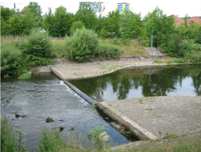
Bild 7: Donaueschingen-Brigach 2003-07-22 Einschnürungsbauwerk und Schwelle
