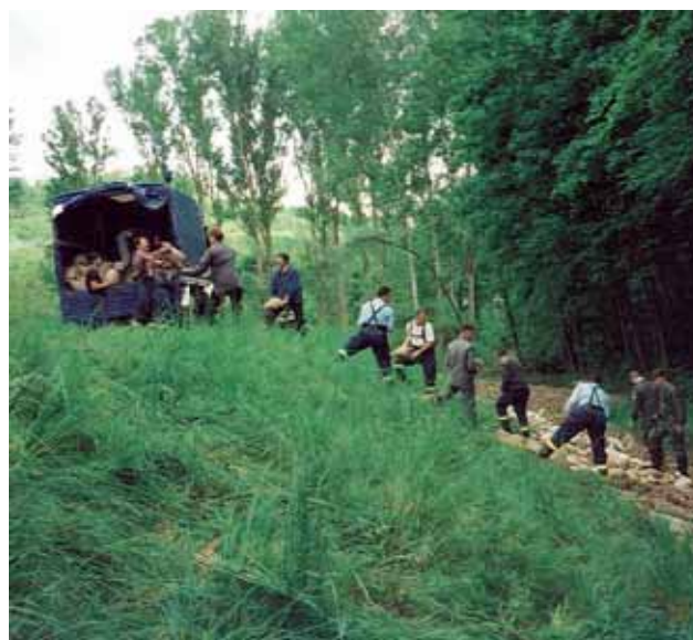
Abb. 5.5: Sandsackkette an der Oder
