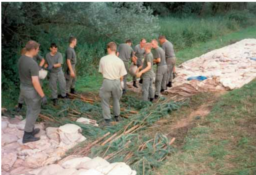
Abb. 5.17: Einsatz von Faschinen und Sandsäcken zur Deichfußsicherung beim Oderhochwasser
