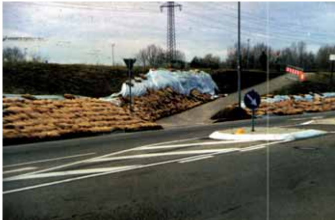
Abb. 5.16: Stützung der landseitigen Böschung mit Sandsäcken auf speziellem Geotextil
