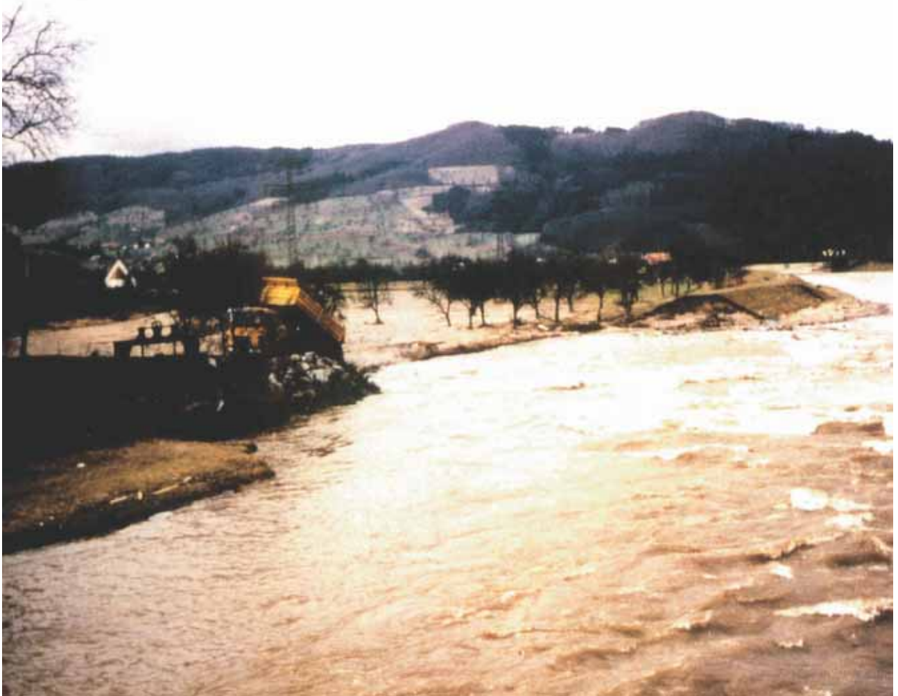
Abb. 5.32: Deichverteidigung bei einem Deichbruch bei Steinach, Kinzig
