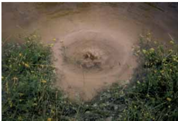
Abb. 2.6: Qualmwasseraustritt mit erosivem Erdstoffaustrag
