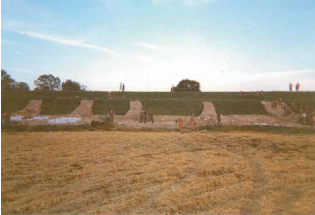
Abb. 5.12: Sandsackquerriegel im Bereich der landseitigen Böschung an der Oder
