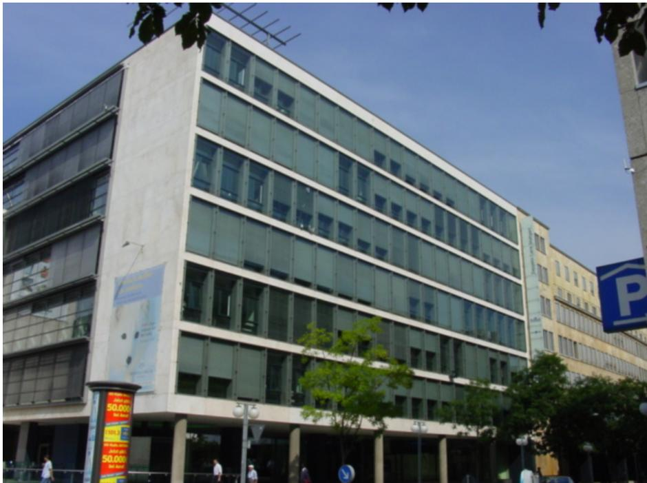
Abb. 69: Zeppelin – Carre´: Doppelfassade (Südostorientierung)
