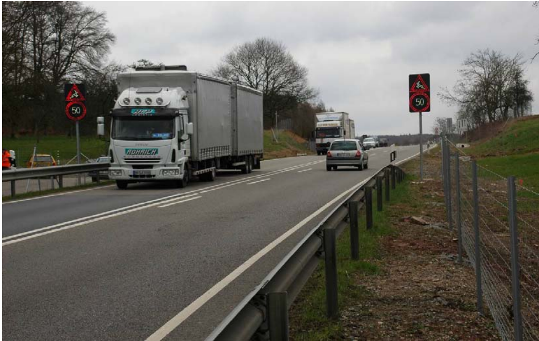
Abb. 2-3: Zentrales Element des Gesamtkonzeptes ist der Wechselbereich für Wildtiere über die Straße, der durch die elektronischen Wildwarnanlage gesichert wird und zur Warnung der Autofahrer blinkende LED-Signaltafeln auslöst. Die Anlage ist tagsüber sonst nicht aktiviert.
