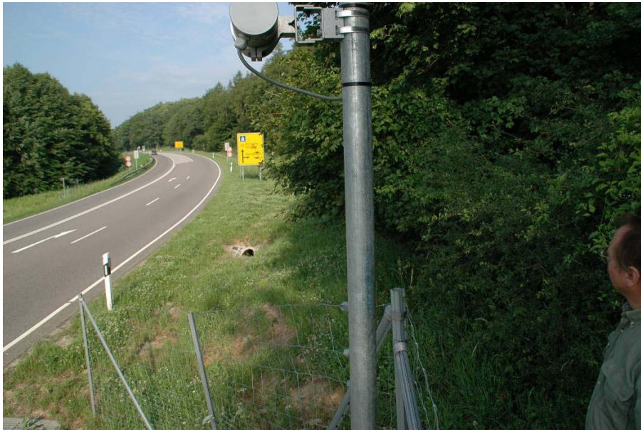
Abb. 4-13: Sensorüberwachter Raum der Anlage 2 Breitenbronn (2007). Eine Beeinträchtigung der Anlage durch die teils in den Sensorstrahl hineinreichende Vegetation ist nicht zu übersehen. Hier ist dringend eine deutliche Rücknahme des Waldrandes erforderlich.
