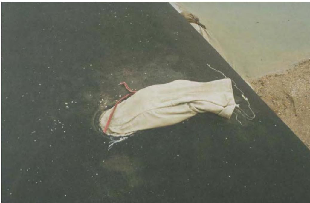
**Bild 10.28:** Fülltechnologie – Geowebestutzen als Ablauf des Einspülwassers
