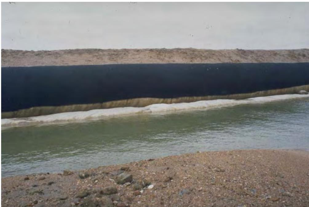
**Bild 10.26:** Sandgefüllter Geogewebeslauch (Megatube) mit einer Höhe von etwa 3 m
