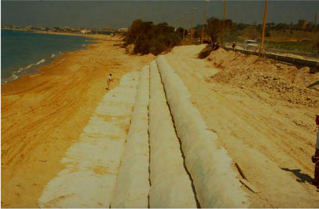
**Bild 10.27:** Sandgefüllte Geogewebesläuche – Bau von Konstruktionen mit größerer Höhe durch Stapelung
