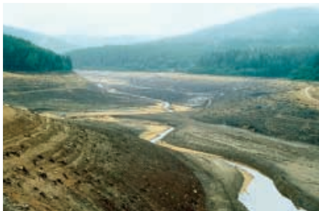
Abgelassene Schwarzenbach-Talsperre bei Forbach im Nordschwarzwald
