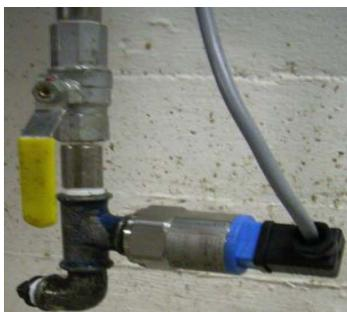
Bild 4.3 Absolutdrucktransmitter
