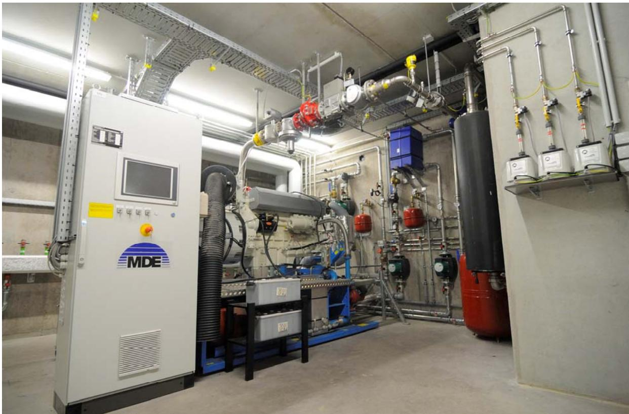
Bild 5.23 Gas-Ottomotor BHKW an der Forschungsbiogasanlage „Unterer Lindenhof“ mit 186 kW elektrischer Leistung
