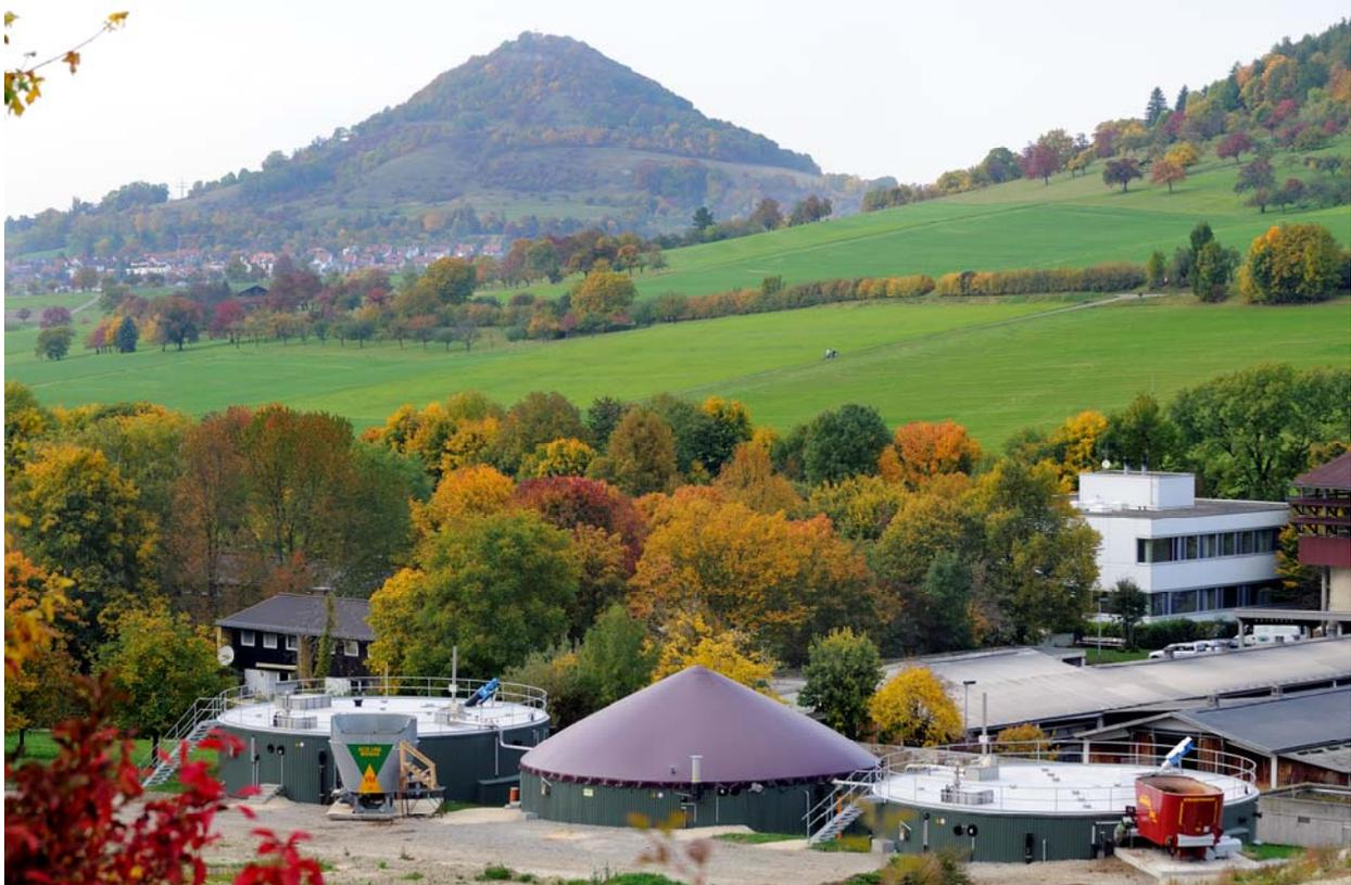
Bild 5.22 Forschungsbiogasanlage „Unterer Lindenhof“ Blick von der Beschickungsseite aus. 2 Fermenter mit Feststoffdosierern, 1 Nachgärfermenter
