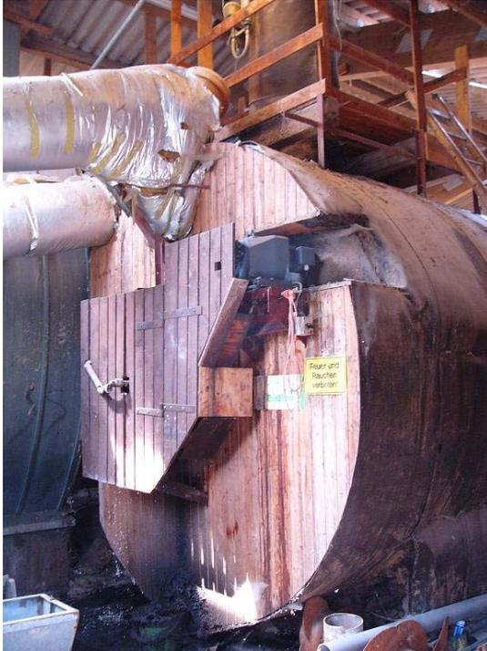
Bild 5.15 Biogasfermenter Erlacher Höhe – liegendes System
