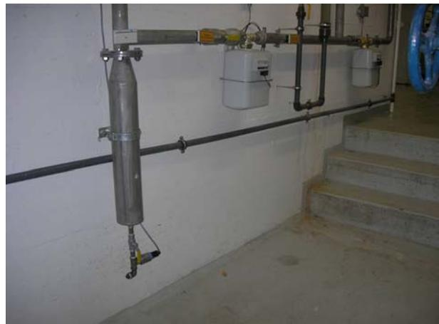
Bild 5.9 Abscheider und Gasdruckmessung
