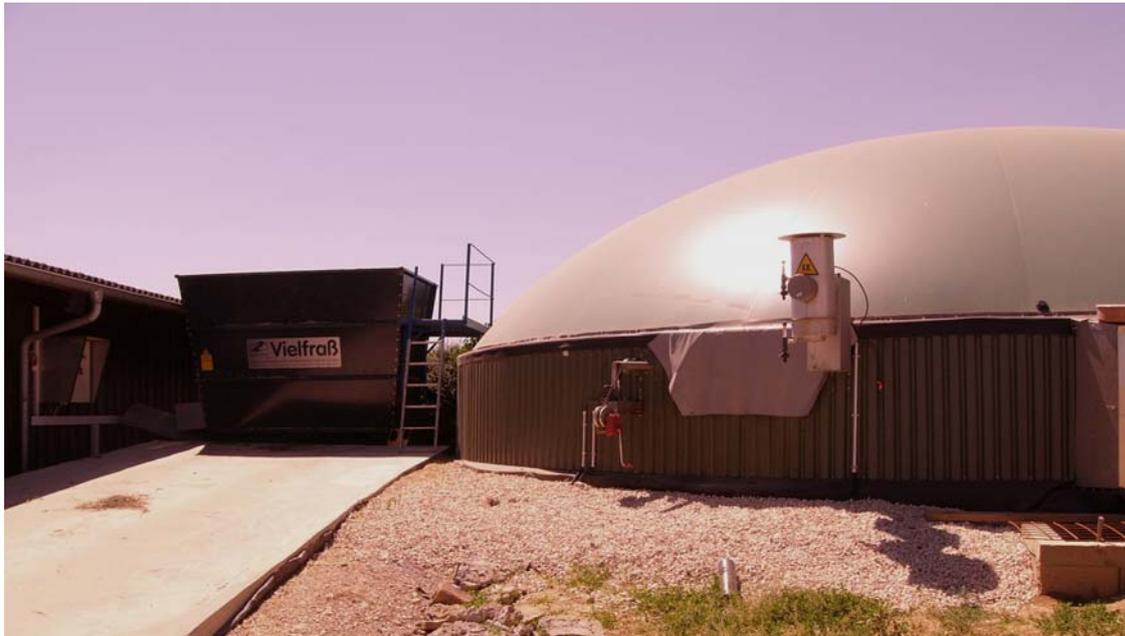
Bild 5.25 Biogasanlage Harthausen – Fermenter mit Substrateintrag
