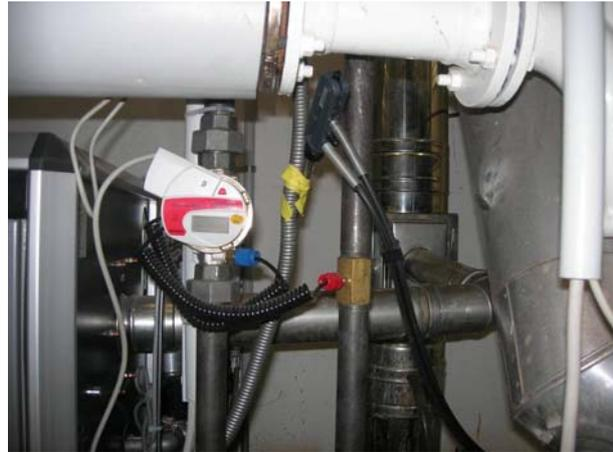
Bild 5.11 Wärmemengenzähler Rosenfeld
