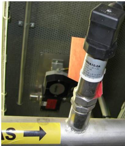
Bild 5.27 Absolutdrucktransmitter
