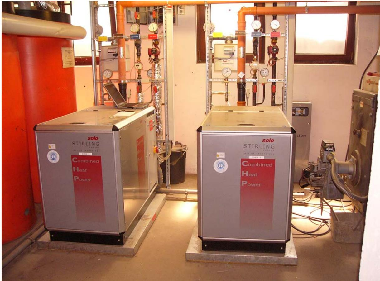
Bild 5.16 Stirling-Motoren am Betrieb Erlacher Höhe
