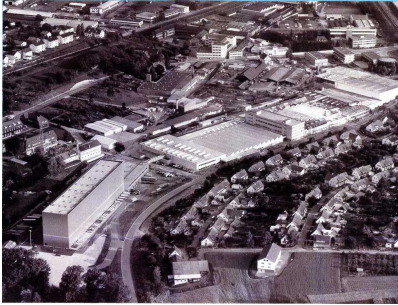
*Luftbild des alten Standortes
