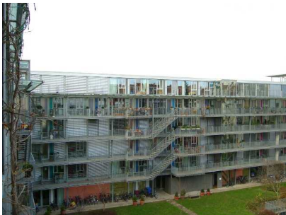
Neuer Wohnkomplex mit Laubengängen
