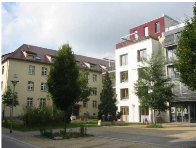
Sanierung im Bestand und Neubau
