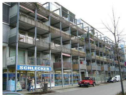
Außenansicht des neuen Komplexes
