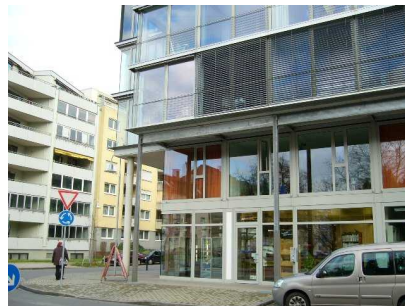
Der neue Komplex von der Straßenseite aus
