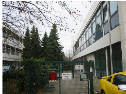
Gewerbegebiet an der Pforzheimer Straße
