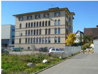
Aufgelassenes und saniertes Gebäude
