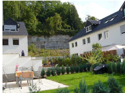
Blick auf die Stützwand
