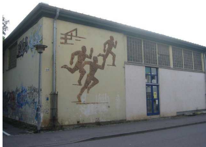
Erhaltenes aufgelassenes Gebäude
