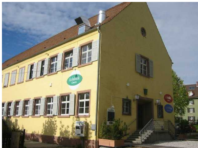
Renovierte Gaststätte – leer stehend
