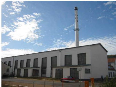
KBC- Gebäude (erhalten geblieben)
