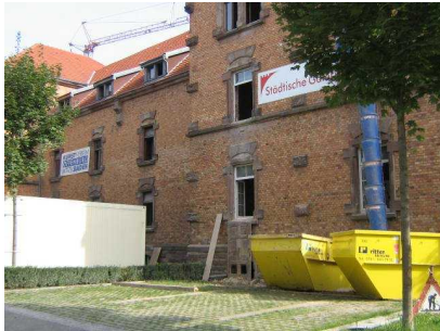
Bauarbeiten an der Städtischen Galerie
