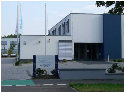
Gebäude des Diakonischen Sozialwerkes
