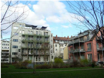
Aus Alt mach Neu. Renoviertes und aufgestocktes ehemaliges Bürohaus, Hofseite (weiß)
