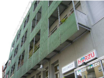
Renoviertes ehemaliges Bürohaus, Straßenseite
