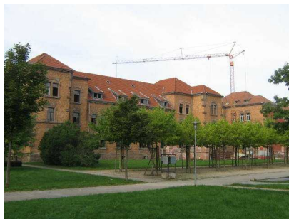
Umbau der Städtischen Galerie
