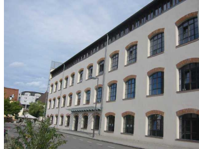
Renoviertes Industriedenkmal – Innocel-Gebäude
