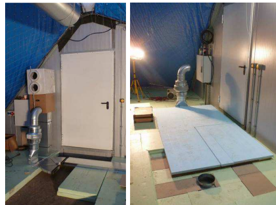
Abb. 91: Eingangsbereich mit Bodenplatten zur besseren Lastverteilung
