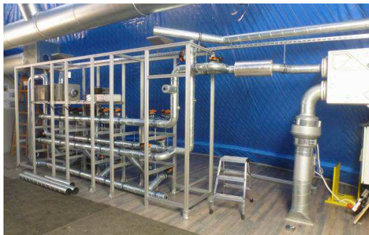
Abb. 94: Aufbau des Montagerahmens für die Luftführung des Speichersystems
