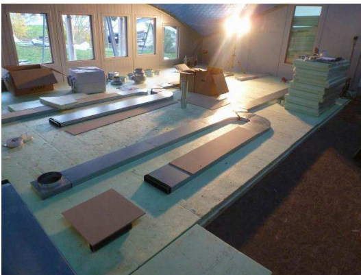
Abb. 90: Auslegen der Unterflurluftkanäle
