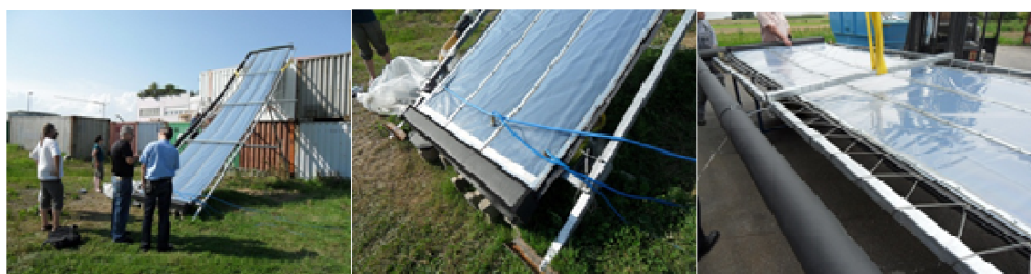
Abb. 74: Fertig erstellter Kollektor für erste Versuchszwecke, nach Süden ausgerichtet, 3 Kollektorbahnen sind mit einem Verteiler- und Sammlerkasten zusammengeschlossen.
