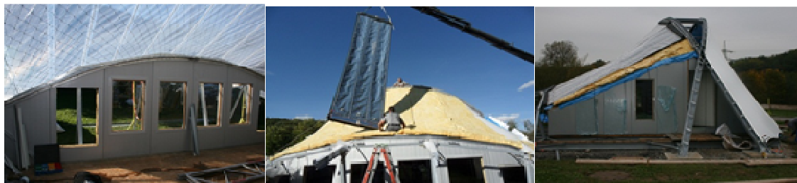
Abb. 76: Wände aus Sandwichpaneelen mit einer Dämmdicke von 140mm (links), Einbau der ersten Kollektorfläche mit einer Einbaulänge von 6m (Mitte), Wärmedämmung im Dachbereich (rechts)
