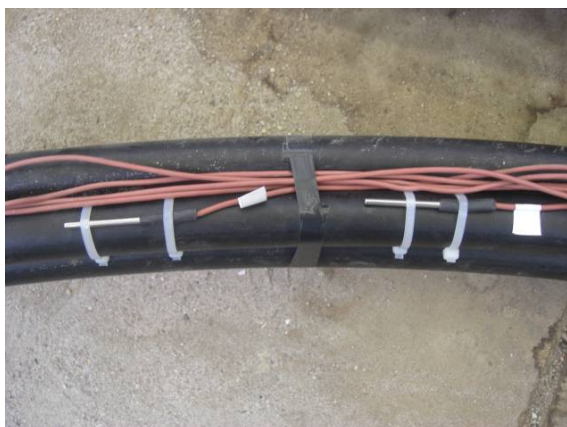
Abbildung 38 Bohrung und Einbau der EWS auf VEGAS Großbehälter
