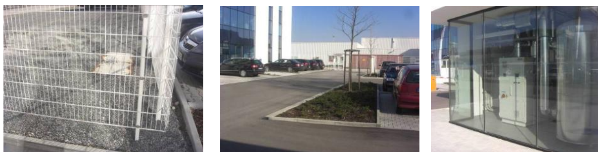
Abbildung 6 Eingebaute Erdwärmesonde auf dem Parkplatz der Bohrfirma (links) und Technikraum (rechts)
