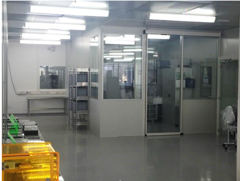
Abbildung 4: Blick auf die Personen- und Materialschleuse über die der Reinraumbereich betreten und verlassen werden kann.
