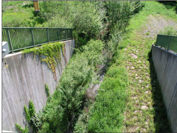
Abbildung 7.16: Hochwasserrückhaltebecken Stadtseebach oberhalb Durchlass (SCHWENNINGER).
