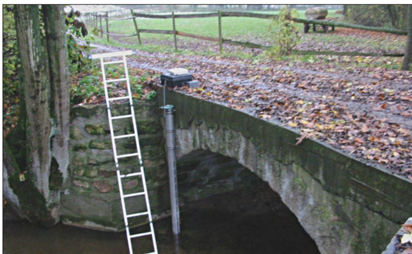
Abbildung 5.5: Installierter Pegel oberhalb der Stauwurzel des Hochwasserrückhaltebeckens A4 bei der Kläranlage Geddelsbach.
