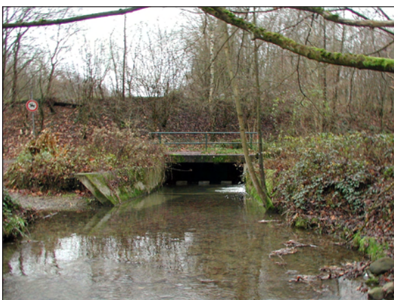
Abbildung 7.26: Hochwasserrückhaltebecken Freiburg Nord. Durchlassbauwerk fotografiert von oberhalb, im Durchlass, von unterhalb und der Seitendamm.
