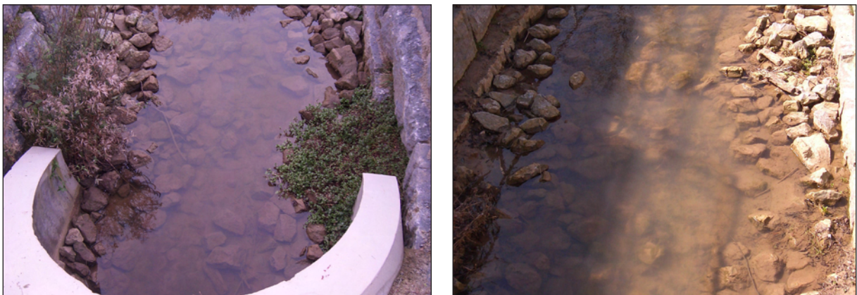
Abbildung 7.42: Abgesetztes Feinmaterial auf der Steinsohle im Durchlass des Beckens S43.
