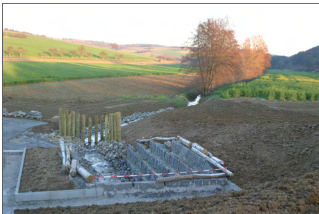
Abbildung 7.37: Ein- und Auslaufbereich am Hochwasserrückhaltebecken Insenbach in der Bauphase. Unterhalb des Durchlasses schließt ein weiterer Durchlass an (Bild rechts)(MEIER).
