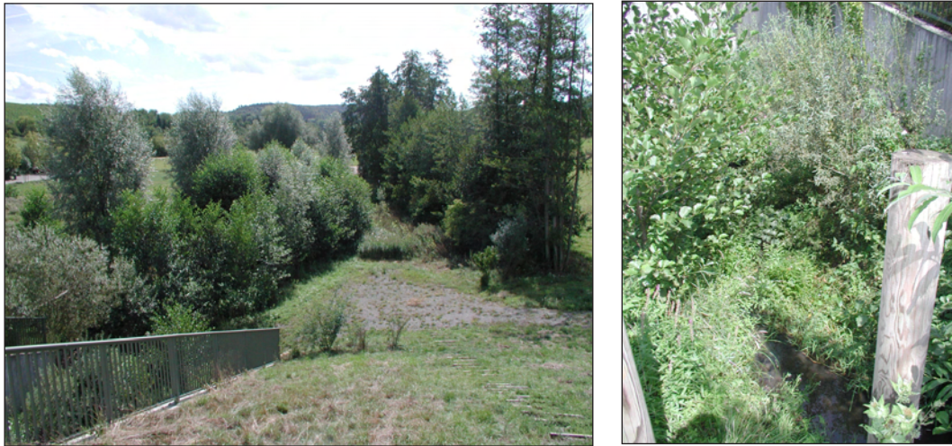
Abbildung 7.38: Gehölzstrukturen oberhalb und in der offenen Dammschleife des Hochwasserrückhaltebeckens Stadtseebach.
