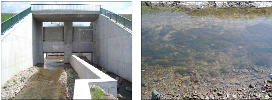
Abbildung 5.30: Gewässerabschnitt am Hochwasserrückhaltebecken im Mai 2006. Im rechten Bild ist deutlich das starke Algen- und Quellmooswachstum zu sehen. Die Uferbermen sind hingegen bisher kaum bewachsen (Bild links).
