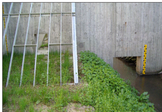
Abbildung 7.17: Hochwasserrückhaltebecken Stadtseebach, Betriebsauslass mit glatter Betonschwelle, sowie Betriebs und Ökodurchlass von oberhalb.
