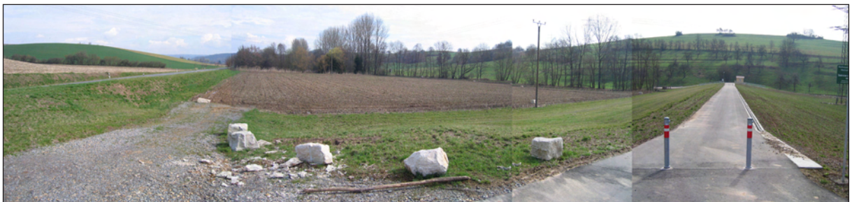
Abbildung 8.11: Blick über Dammkrone (SW).
