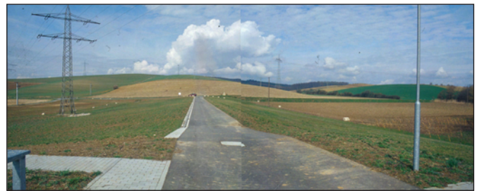
Abbildung 8.10: Blick über Dammkrone (NO).
