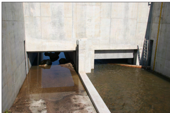
Abbildung 5.38: Mangels terrestrischer Habitate können die Durchlässe nicht von laufaktiven Käfern genutzt werden. (Aufnahme am 03.06.06) (BÜRO ENTOMOLGIE + ÖKOLOGIE 2006).
