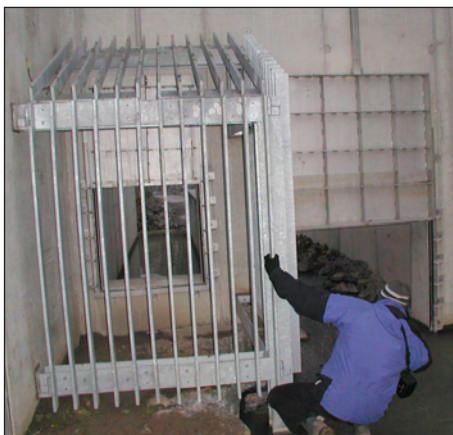
Abbildung 7.41: terrestrische Durchlässe sollten ebenerdig und nah an der Seitenwand angebracht werden, um Tieren die Durchwanderung zu ermöglichen ( Skizze links). Erhöhte Bodenschwellen können gerade für Laufkäfern Hindernisse darstellen (Skizze rechts). Das Photo zeigt den Betriebs- und Ökodurchlass am Hochwasserrückhaltebecken Gemmingen-Staubach. Der Durchlass ist so hoch angebracht, dass selbst Reptilien und Amphibien die Schwelle nur schwer überwinden können (Bild: F. SEIDEL).
