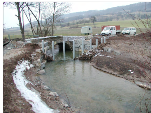
Abbildung 5.29: Beim Hochwasser am 9. März 2006 wurden größere Mengen an Feinsediment an der Probestelle P2 abgelagert, auch kam es zu erheblichen Sohlumlagerungen. Beim Hochwasser wurde auch Material aus einer Baustelle oberhalb von P2 ausgewaschen.
