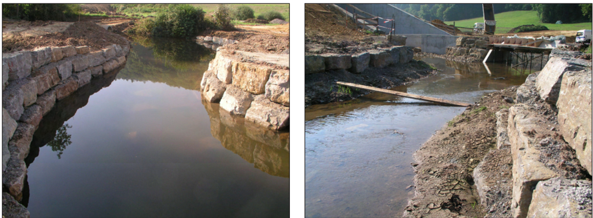
Abbildung 5.36: Hochwasserrückhaltebecken Hälden, Einlauf- und Auslaufbereich (Aufnahme am 01.09.05). (BÜRO ENTOMOLOGIE + ÖKOLOGIE 2006).
