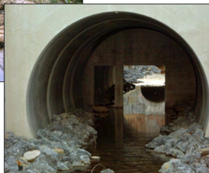
Abbildung 7.34: Hochwasserrückhaltebecken Insenbach S43. Damm im Bau, sowie Durchlassbauwerk fotografiert von unterhalb und oberhalb.
