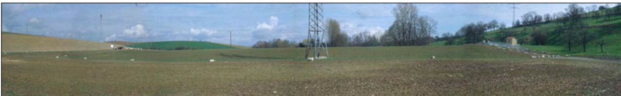
Abbildung 8.25: Damm luftseitig, nah.
