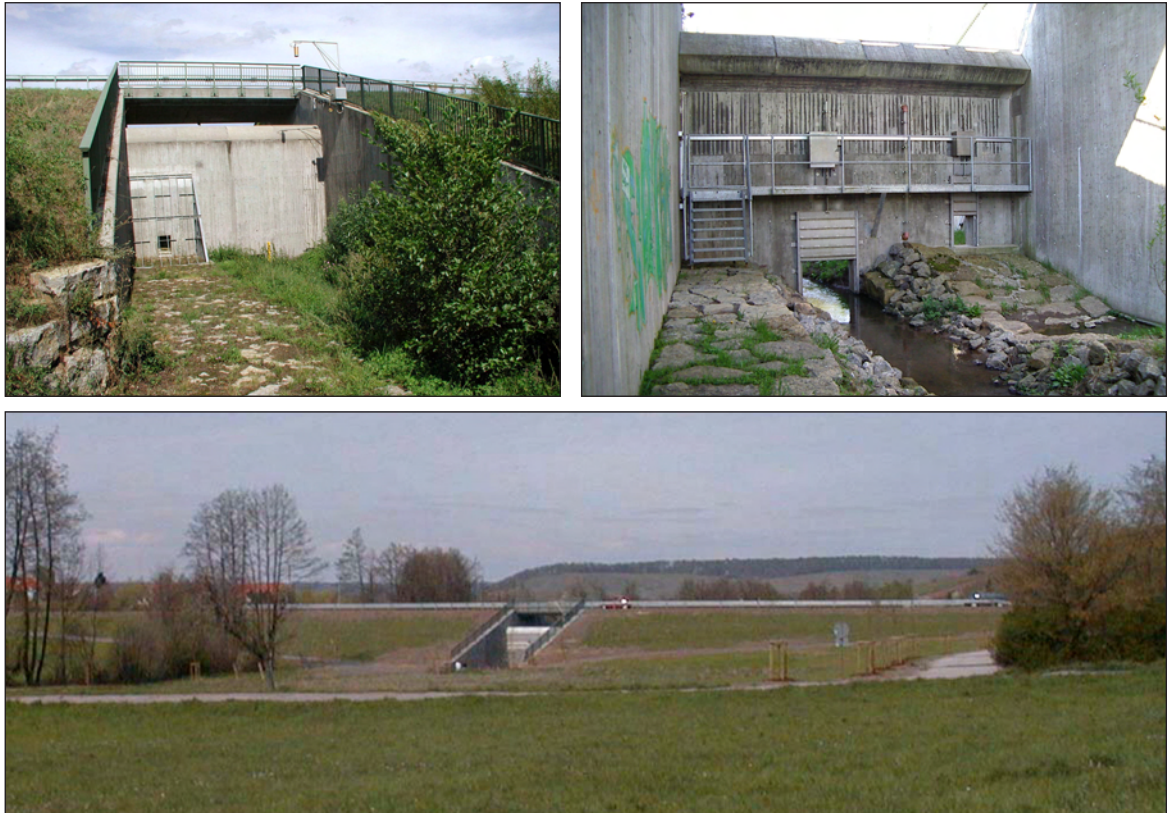
Abbildung 7.2: Hochwasserrückhaltebecken Stadtseebach. Durchlassbauwerk fotografiert von oberhalb und unterhalb, sowie der Damm (EIGENE AUFNAHME; KUNZE; INGENIEURBÜRO W&P).
