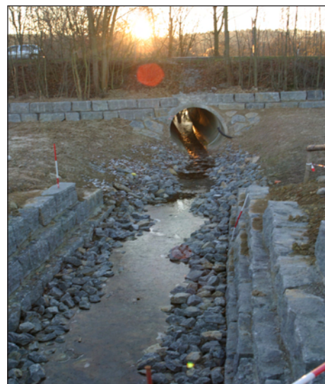
Abbildung 7.37: Ein- und Auslaufbereich am Hochwasserrückhaltebecken Insenbach in der Bauphase. Unterhalb des Durchlasses schließt ein weiterer Durchlass an (Bild rechts)(MEIER).
