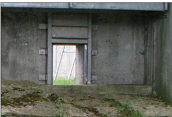
Abbildung 7.17: Hochwasserrückhaltebecken Stadtseebach, Betriebsauslass mit glatter Betonschwelle, sowie Betriebs und Ökodurchlass von oberhalb.
