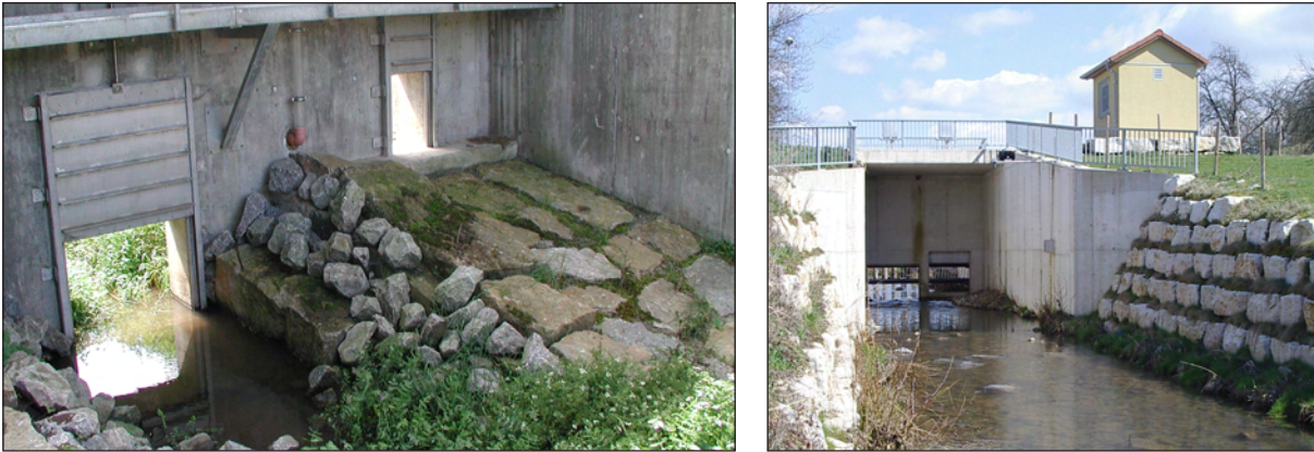
Abbildung 7.39: Steuerschieber an den Hochwasserrückhaltebecken Stadtseebach (links) und Mönchzell M18 (rechts) verbessern die terrestrische Durchgängigkeit. Am Hochwasserrückhaltebecken M18 ist jedoch die Uferberme stellenweise nicht ausreichend ausgebildet.
