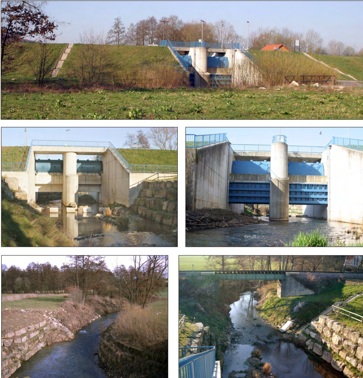
Abbildung 7.19: Hochwasserrückhaltebecken Waibstadt W18. Damm mit Durchlassbauwerk, Schütze mit Fischbauchklappen fotografiert von unterhalb und oberhalb, sowie Ein- und Auslaufbereich (EIGENE AUFNAHMEN).
