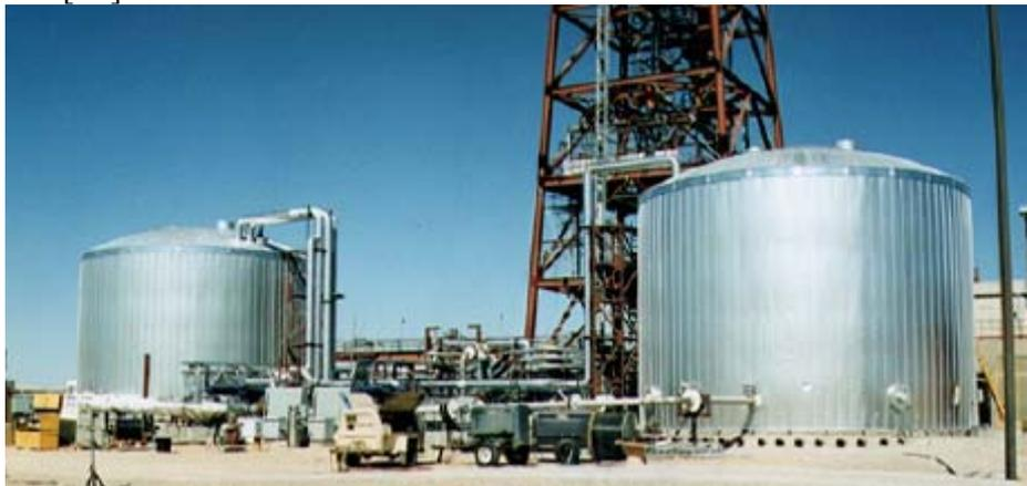
Fig.5: Kalttank und Heißtank eines Salzschnmelze-Speichersystems, eingesetzt im solarthermischen Solar Two Kraftwerk [14]
