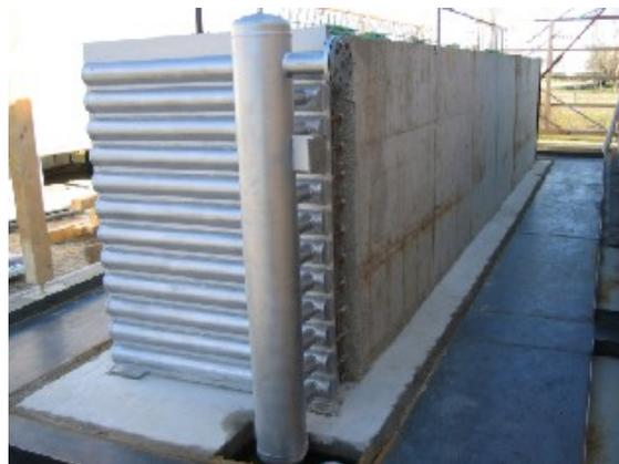
Fig.7: Feststoffspeicher mit Beton als Speichermedium mit  $400\text{kWh}$  Speicherkapazität, maximale Temperatur bei  $400^\circ\text{C}$  [17].
