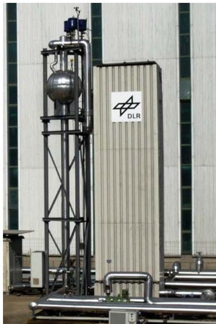
Fig.8: Latentspeichermodule für Dampf bei ca. 100bar, Leistung 700 kW, Speicherkapazität 700 kWh
