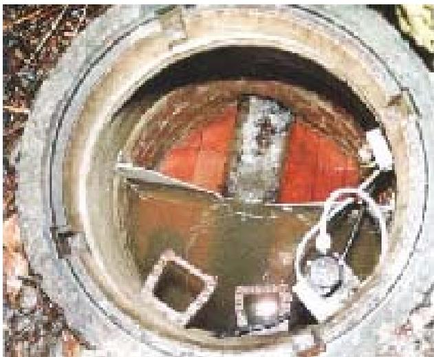
Abb. 6: Messschacht mit eingebautem Dreieckswehr und Wasserstandsmessung (für langfristige Messungen) (Quelle: IKT)
