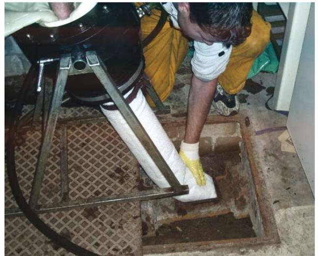
Abb. 27: Schlauchlinersanierung über einen Revisionsschacht innerhalb eines Hauses: Inversion des Inliners (links), Freischneiden des Liners (rechts)
