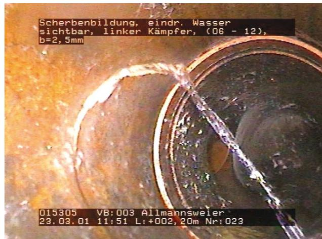
Abb. 21: Grundwasserinfiltration (Quelle: Gebr. Förster GmbH, Schwana)
