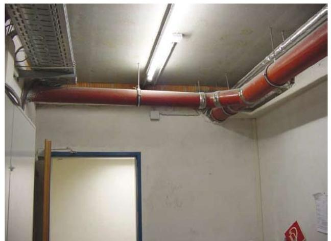
Abb. 28: Beispiel für ein unter der Kellerdecke abgehängtes Entwässerungssystem
