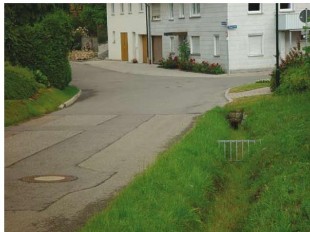
Abb. 22: Einleitung einer Aussengebiete drainage aus einem Wegeseitengraben in das Kanalisationsnetz
