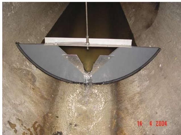
Abb. 3: „Mobiles“ Messwehr (für kurzzeitige Messungen)
