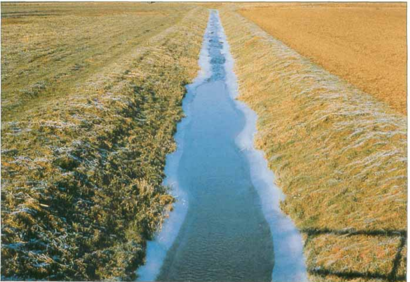
Der Kamm Bach vor der Umgestaltung: Schnurgerade, Trapezprofile, Böschungen regelmäßig gemäht, keine Gehölze; ein für das Acher-Rench-Korrektionsgebiet typisches Gewässer. (Hämmerle 2/86)
