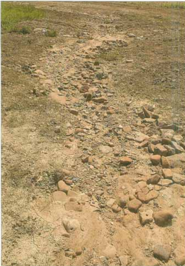
Das noch nicht geflutete Mittelwasserbett erhielt ein breit gestuftes Korngemisch, so daß sich bei Hochwasser eine naturgemäße Bettmorphologie einstellen kann (Bostelmann 7/91).
