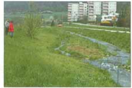
Die streckenweise großzügige Neugestaltung des Bachbetts führt bei höheren Abflüssen zu Verzweigungen und Inselbildungen (Czerniak 4/89).
