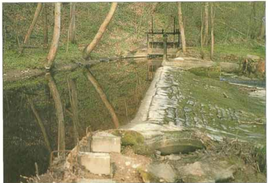
Gewässernutzungen im Einzugsgebiet; hier: Wehranlage an der Glems (All).
