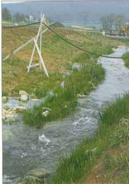
Der erhöhte Frühjahrsabfluß verdeutlicht die Struk-turvielfalt des neuen Bachbettes. Das Strömungs-mosaik wird sich mit Aufwachsen der gepflanzten Erlen weiter verändern. Das Stromkabel weist auf die gerade erst begonnene Erschließung des Neu-baugebietes hin, das der Bach zukünftig durchflie-ßen wird (Czerniak 4/89).
