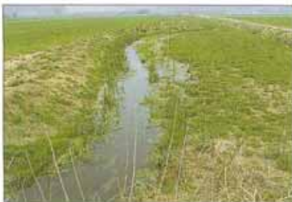
Ein etwa 20 m breiter Geländestreifen wurde erworben und als „Ersatzaue“ abgegraben. Das neue Mittelwasserbett pendelt mit leichten Bögen. (Kern 4/88)
