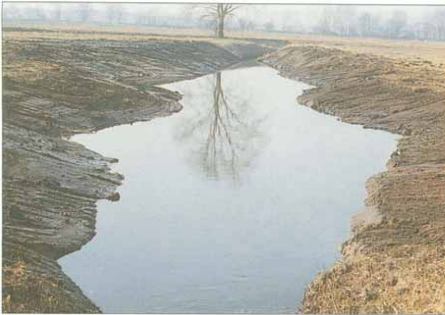
Der etwa 70 m lange Schlammfang wurde mit flachen Uferböschungen angelegt; eine Räumung ist vom Ufer aus über die Böschungsbereiche hinweg möglich (Humborg 2/91).
