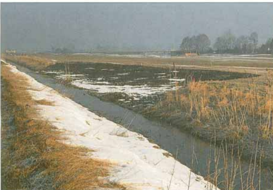
Soweit es die Gelände- und Eigentumsverhältnisse zuließen, wurde wechselseitig abgegraben, um an beiden Ufern aueähnliche Standortbedingungen zu schaffen (Humborg 2/91).
