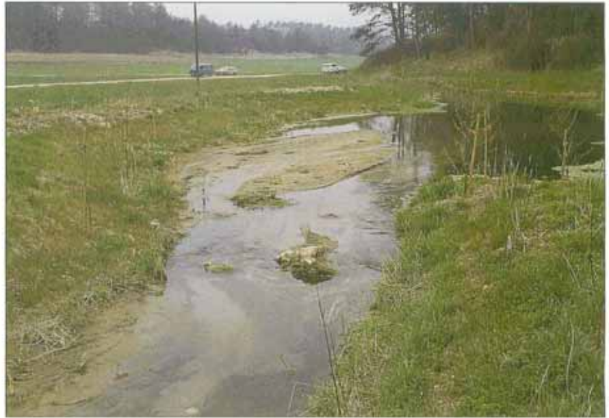
Sedimentationsbecken am Siegentalgraben zur Minderung des Stoffeintrages in den Schmiecher See. Ein Hochwasser hat erste Geschiebemengen abgelagert. (Kern 4/88)
