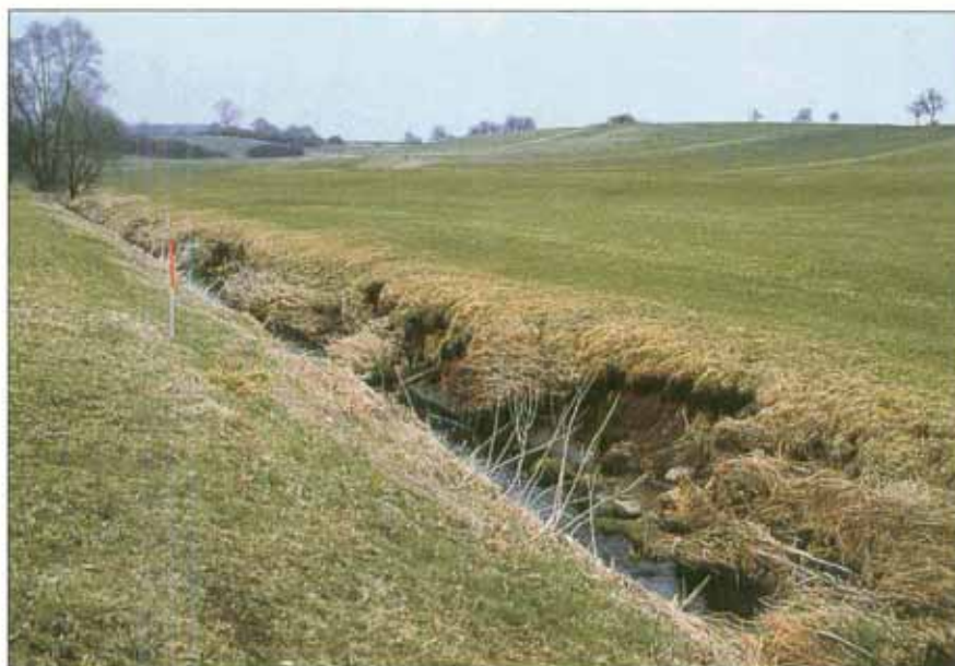
Vor der Umgestaltung wies der Steinbach ein tief eingeschnittenes, von Erosionsschäden gekennzeichnetes Bett auf (Horlacher 5/86).
