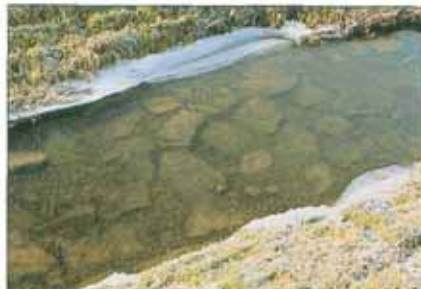
Das damals eingebrachte Sohlenpflaster erwies sich später als überflüssig, da die Strecke zur Auflandung neigt und regelmäßig ausgeräumt werden muß. (Hämmerle 2/86)
