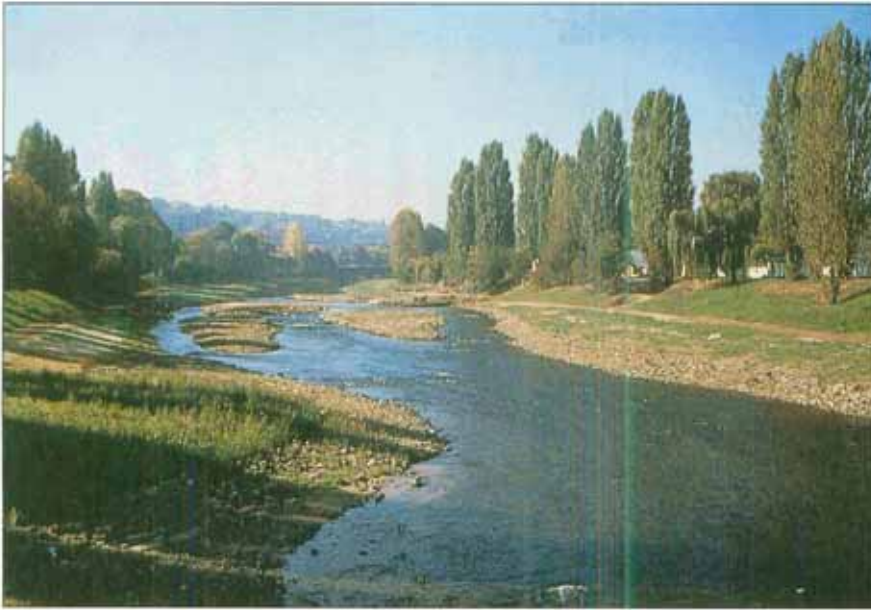
In Aufweitungsbereichen wurden Inseln ins Mittelwasserbett gebaut, dazwischen verengen Vorsprünge das Flußbett. Beides führt zu einem vielfältigen Strömungsmuster mit einem größeren Lebensraumangebot (Mayer-Peters 10/90).
