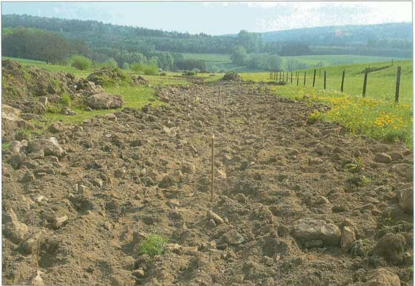
Grobplanie zur Herstellung des neuen Bachlaufs. Der Untergrund enthielt reichlich Grobmaterial, das für den Sohlenaufbau verwendet werden konnte (Bostelmann 5/91).
