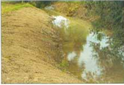
Auf dem größten Teil der Strecke wurde das Bett unter Schonung des vorhandenen Bewuchses aufgeweitet und die Böschungen abgeflacht (Kern 8/88).
