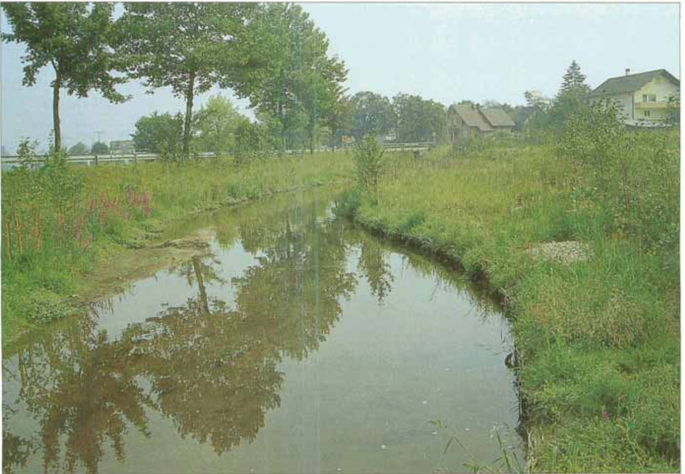
Ein Hochwasser führte kurz nach Fertigstellung zu geringfügigen Auflandungen (Scherle 8/90).
