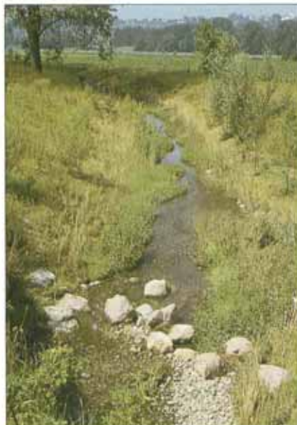
Innerhalb des Hochwasserbetts wurde eine geschlängelte Mittelwasserführung angestrebt, die durch die aufkommende Vegetation verstärkt wird (Gebler 7/89).
