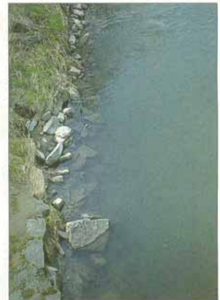
Böschungspflaster und Steinsatz zur Fußsicherung (Alt).
