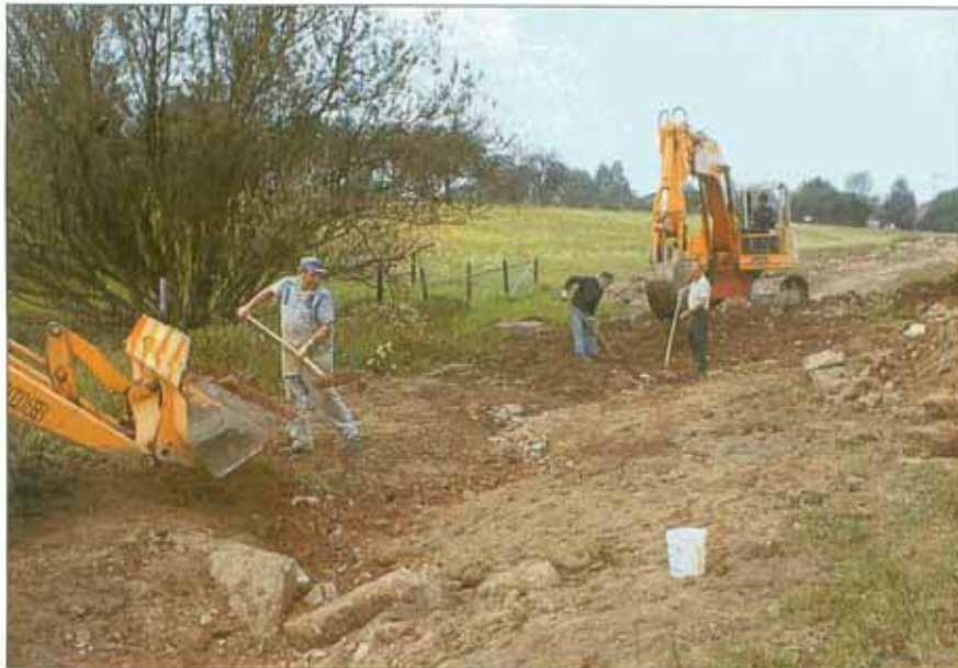
Herstellung des Mittelwasserbetts mit grobkörniger Sohlenauflage und Steinriegeln in Gefällstrecken (Hauck 6/91).
