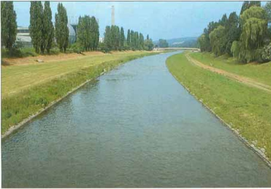
Wie viele Flüsse in Baden wurde die Enz Anfang des Jahrhunderts mit einem regelmäßigen Doppeltreppprofil ausgebaut. Die Böschungen des MW-Bettes sind mit Steinsatz befestigt (Maerzke 3/90).
