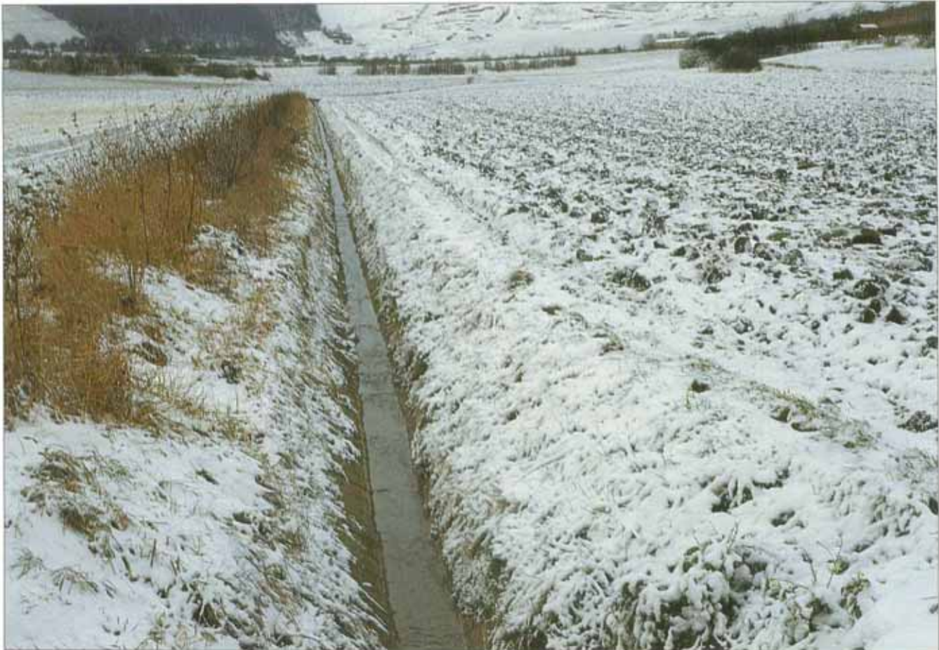
Tief eingeschnitten und mit Sohlshalen befestigt zeigt sich der Eberbach auf Gemarkung Eberstadt (Kern 11/88).
