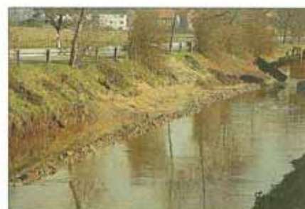
Entlang von Straßen oder Siedlungen wurde zunächst eine Steinschüttung am zukünftigen Böschungsfuß eingebracht, anschließend die Böschung abgezogen und später bepflanzt (Scherle 2/90).
