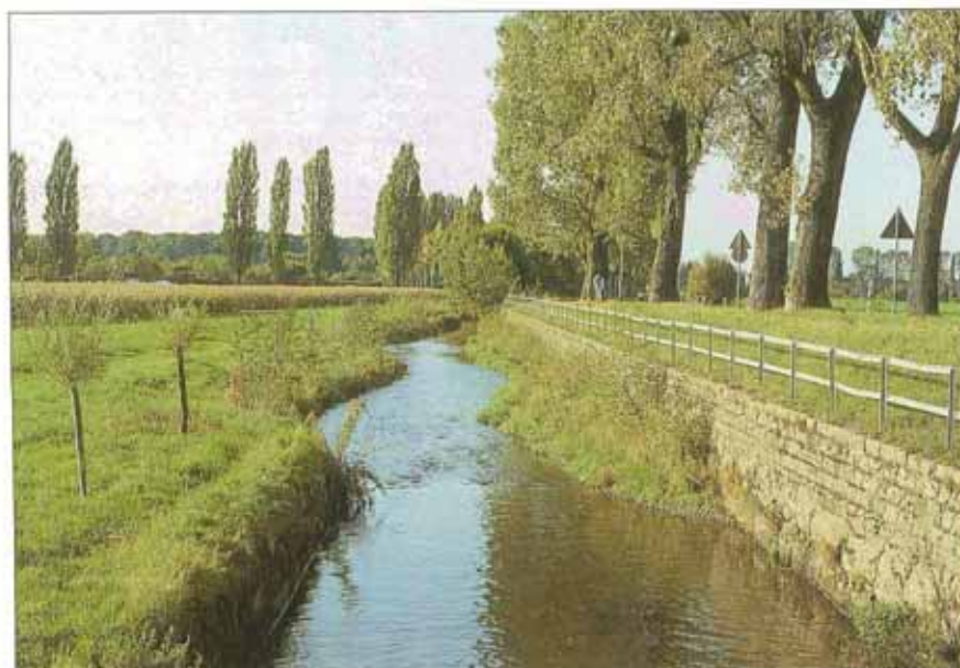
Ein Jahr nach der Umgestaltung sind die Berme und das abgeflachte Ufer dicht bewachsen. Im Vordergrund sind Weidensetzstangen zu erkennen, die als Kopfweiden gezogen werden. Im weiteren Verlauf schließt sich ein dichter, aus verschiedenen Sträuchern und Baumarten aufgebauter Gehölzstreifen an (Czerniak 7/88).
