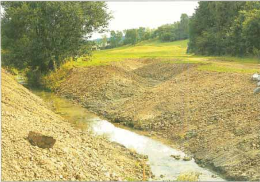
An einer Stelle konnte der Bach in sein altes Bett zurückverlegt werden. Die alten Bettsedimente sind an ihrer grauen Färbung zu erkennen. Der begräbte Bachlauf wurde zur Hochwasserabfuhr beibehalten (Kern 8/88).
