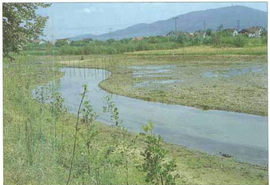
Ein Hochwasser führte kurz nach Fertigstellung zu geringfügigen Auflandungen (Scherle 8/90).
