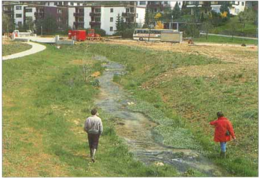
Innerhalb des zur Hochwasserabführung stark auf-geweiteten Bachbettes wurde streckenweise eine leicht geschwungene Linienführung verwirklicht. Kleinräumige Schlängelungen entstehen außerdem durch zusammenhängende Polster der Bachbunge (Czerniak 4/89).
