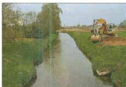
Auf den ersten Bauabschnitten des naturnahen Sandbachausbaus waren allenfalls einseitige Aufweitungen der Gewässerparzelle möglich, die wiederum von einem parallel verlaufenden Abwasser-sammler begrenzt wurden (Scherle 4/90).
