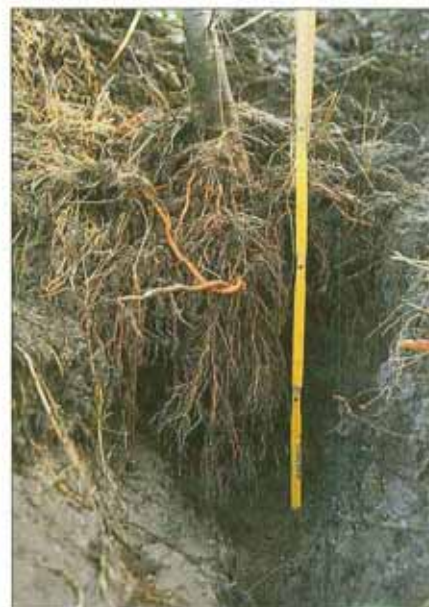
Nach zwei Vegetationsperioden können an der Mittelwasserlinie gepflanzte Erlen die Sicherung des Böschungsfußes übernehmen (Nadolny 10/88).
