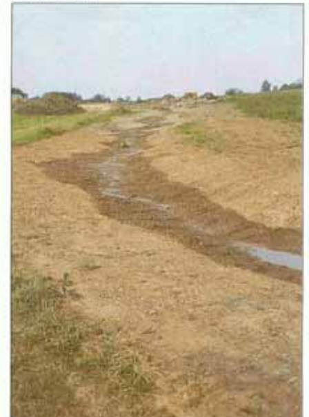
Mit einem Flutungsversuch nach Fertigstellung der Erdarbeiten und Aussaaten wurde die Reaktion des neuen Bachbettes auf den Abfluß getestet (Hauck 6/91).
