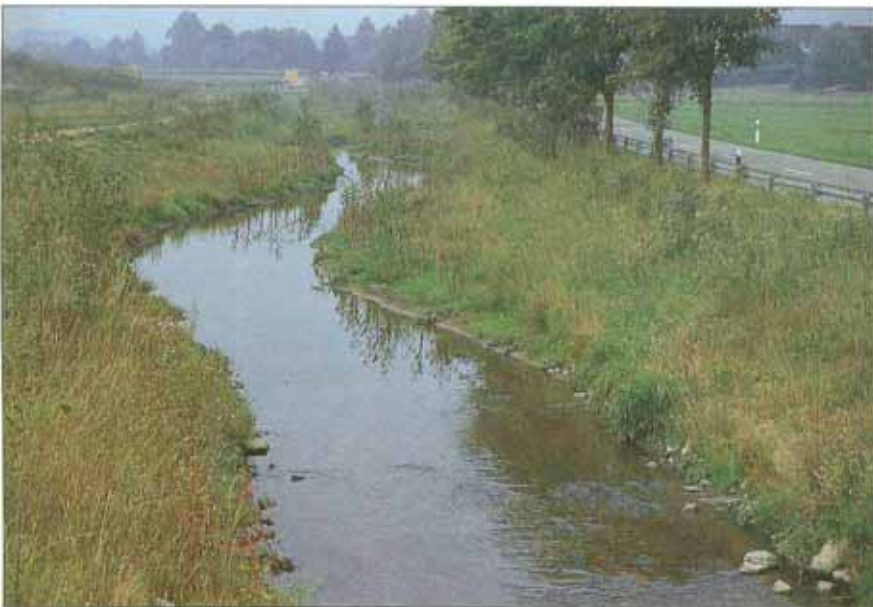
Ein halbes Jahr nach dem Bau hat sich bereits ein üppiger Krautwuchs eingestellt (Scherle 8/90).
