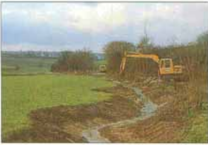
Wenige Tage später entstand das neue Bett unter Schonung der Gehölze. Auf eine Feinplanung wurde zugunsten der bewährten Tagesbesprechung vor Ort verzichtet (Wolf 12/88).
