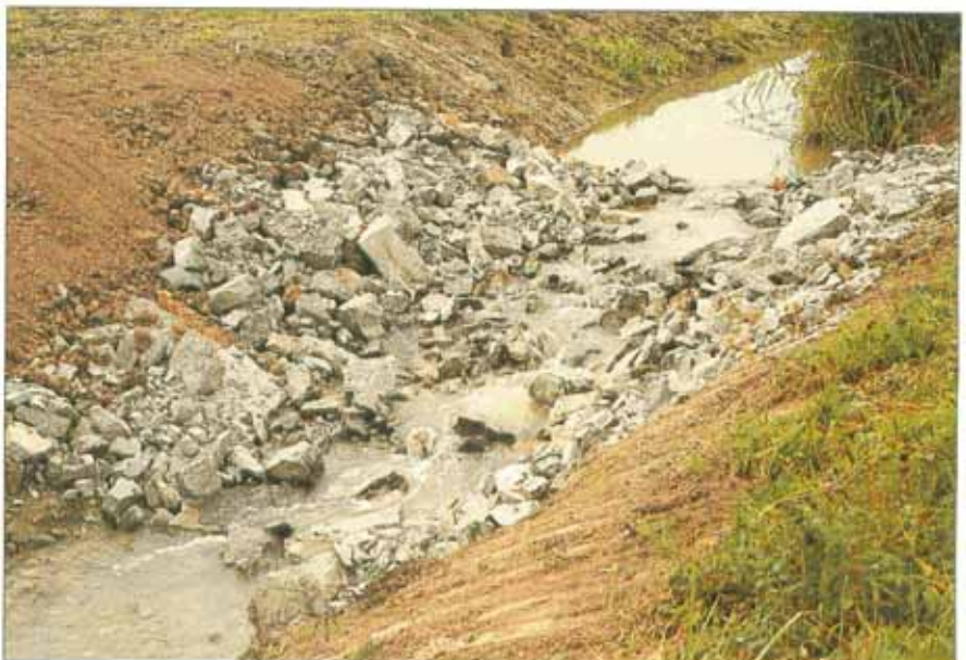
Die fertiggestellte Sohlgleite. Das auf Hochwasserbeanspruchungen ausgelegte Bauwerk dürfte bei Niedrigwasser einen Fischwechsel erschweren. Zur Vermeidung allzu großer Rückstaubereiche wurden später die Oberkanten der Rampen etwas abgesenkt (Kern 8/88).
