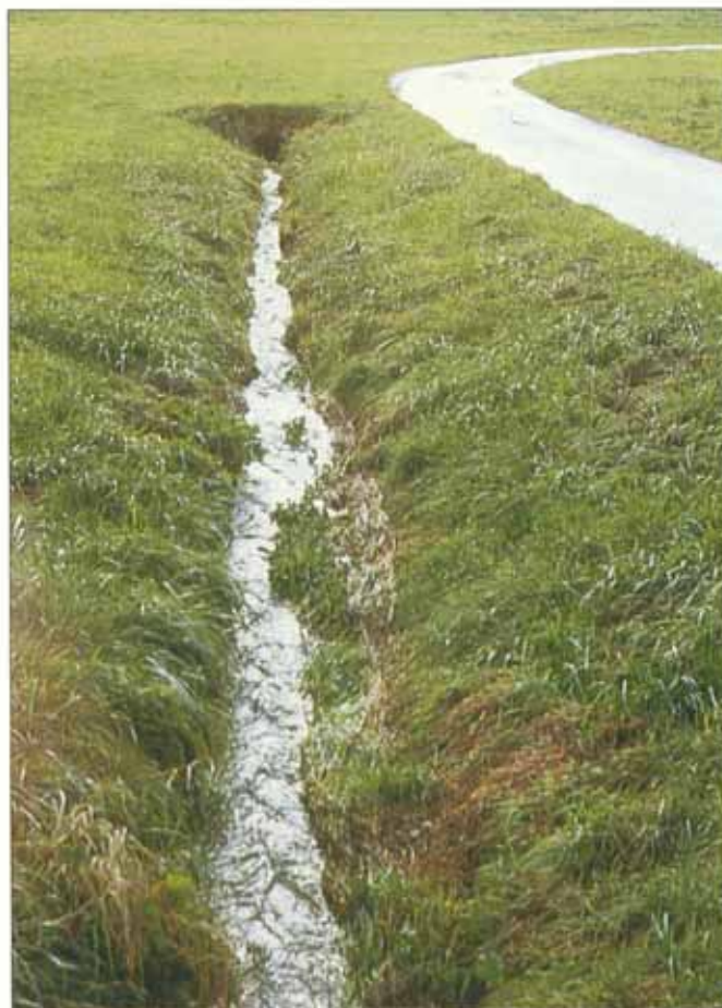
Vor der Umgestaltung durchfloß der Sulzbach als einförmiger Graben das flurbereinigte Gebiet. Im Hintergrund der Beginn einer 120 m langen Verrohrung, die ohne ersichtlichen Grund eingebracht wurde (Wolf 10/86).
