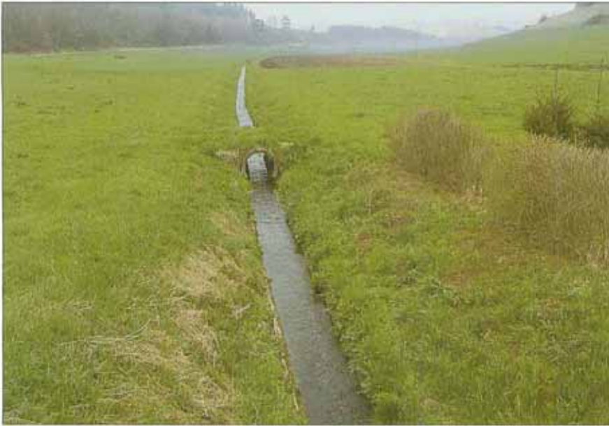
Der gehölzfreie, schnurgerade, mit Sohlsohlen versehene Oberlauf des Siegentalgrabens weist keine Merkmale eines Wiesenbaches mehr auf. (Kern 4/88)
