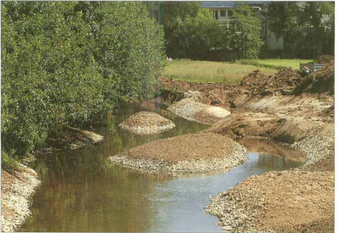
Im unteren Bereich der Umgestaltungstrecke konnten in einer Aufweitung Inseln in das Bachbett eingelagert werden, um eine ausgeprägte Wasserwechselzone zu erhalten und Rückzugsgebiete für Tier- und Pflanzenarten zu schaffen (Czerniak 5/87).
