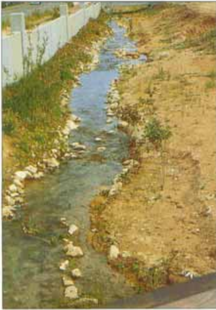
In Bereichen, wo der Gutenbach entlang von Stützwänden fließt, wurden diese mit einer Vor-schüttung versehen, die zusätzliche Wasserwech-selzonen schafft. Eine Begrünung der kahlen Wände mit bachbegleitenden Staudenfluren und Gehölzen ist zu erwarten (Grössle 7/88).
