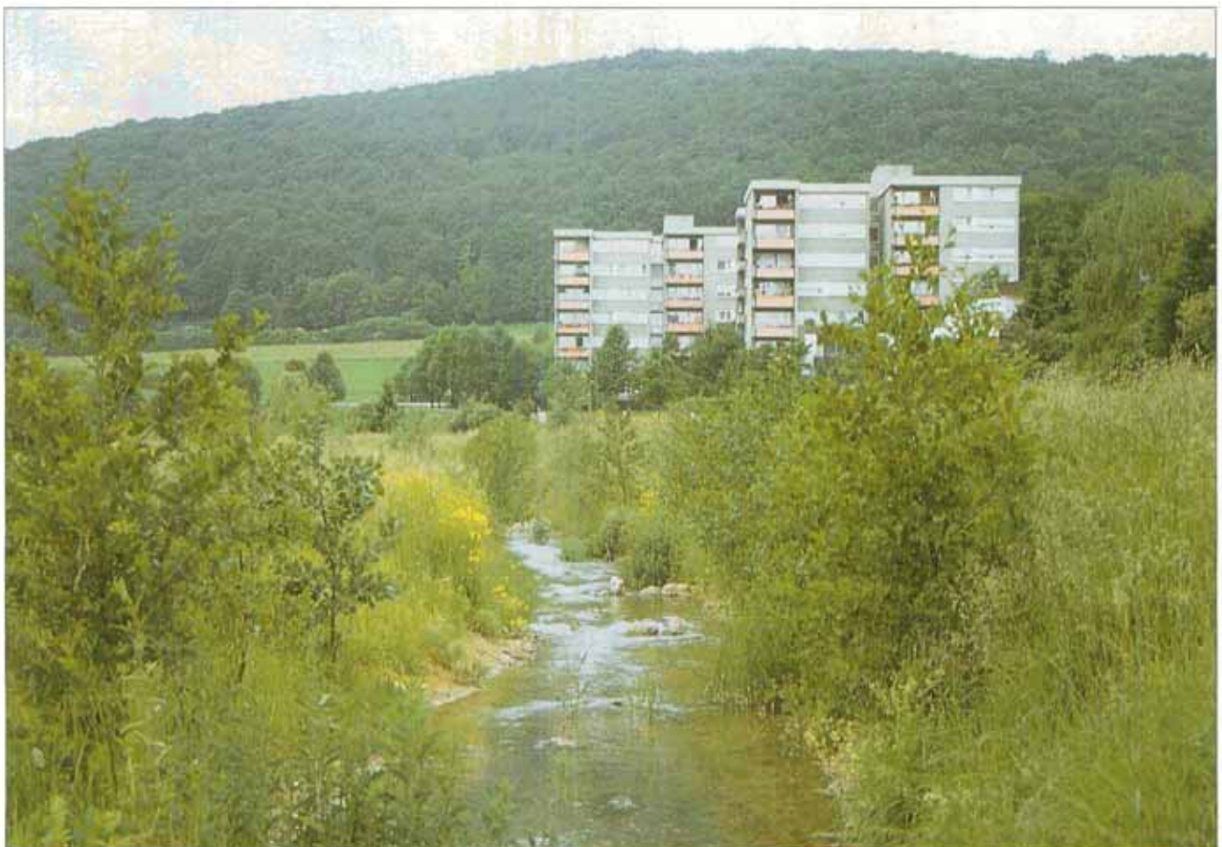
Ein Jahr später ist die Baumaßnahme als solche kaum noch zu erkennen. Die jungen Erlen markieren bereits den Lauf des neuen Gutenbachs (Konold 6/90).
