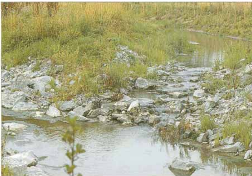
Nach der ersten Vegetationsperiode sind die hergestellten Böschungen bewachsen; die Gehölze haben noch keine Schattenwirkung (Czerniak 8/89).
