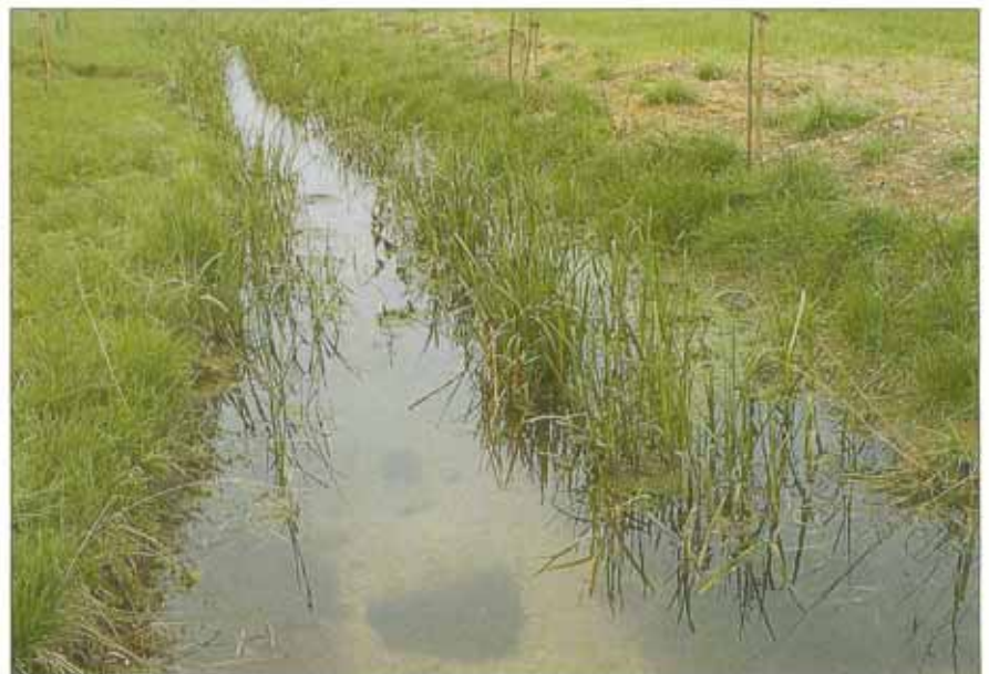
Ein etwa 20 m breiter Geländestreifen wurde erworben und als „Ersatzaue“ abgegraben. Das neue Mittelwasserbett pendelt mit leichten Bögen. (Kern 4/88)
