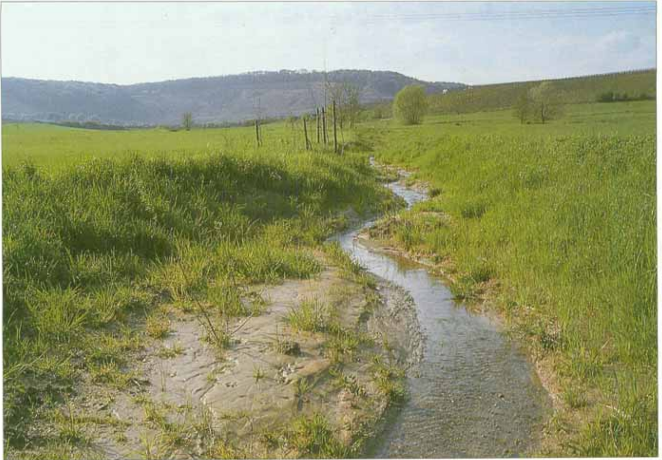
Ein im Rahmen der „Biotopvernetzungsplanung Weißenhof“ 1988 umgestalteter Seitengraben: in einer abgegrabenen Bachau schlängelte sich das unbefestigte Mittelwasserbett (Bostelmann 4/89).
