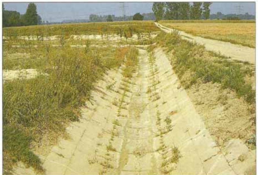
Oberhalb der Versuchsstrecke besteht noch der alte Sohlschalenausbau, der nur den oberen Böschungsbereich unbefestigt ließ (Scherle 8/90).
