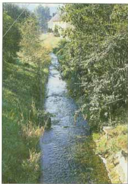
In der Ortslage Möhringen ist der Krahenbach mit einem regelmäßigen Trapezprofil ausgebaut. Pflasterungen der Sohle und der Böschungen unterbinden jede Eigendynamik. (Kern 10/89)
