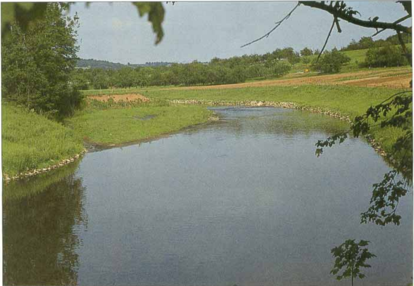
Murr oberhalb Steinheim; Zustand nach dem Durchstich einer Flußschlinge, am linken Bildrand die hierbei entstandene Bucht (Bürkle 1977).
