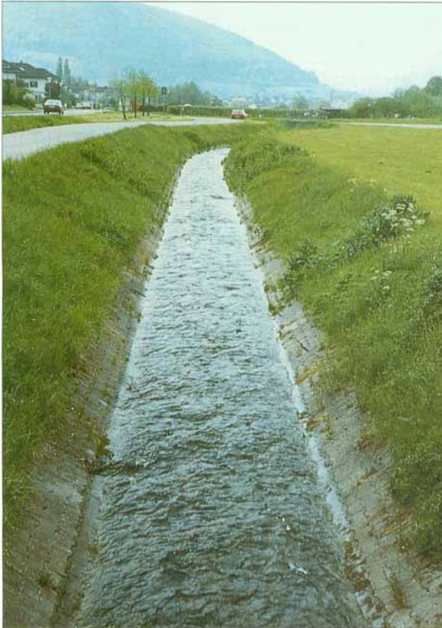
Der Gutenbach wies vor der Umgestaltung ein mit Verbundsteinpflaster ausgekleidetes Trapezprofil auf, welches lediglich auf die unschädliche Wasserabführung ausgerichtet war (Konold 5/84).
