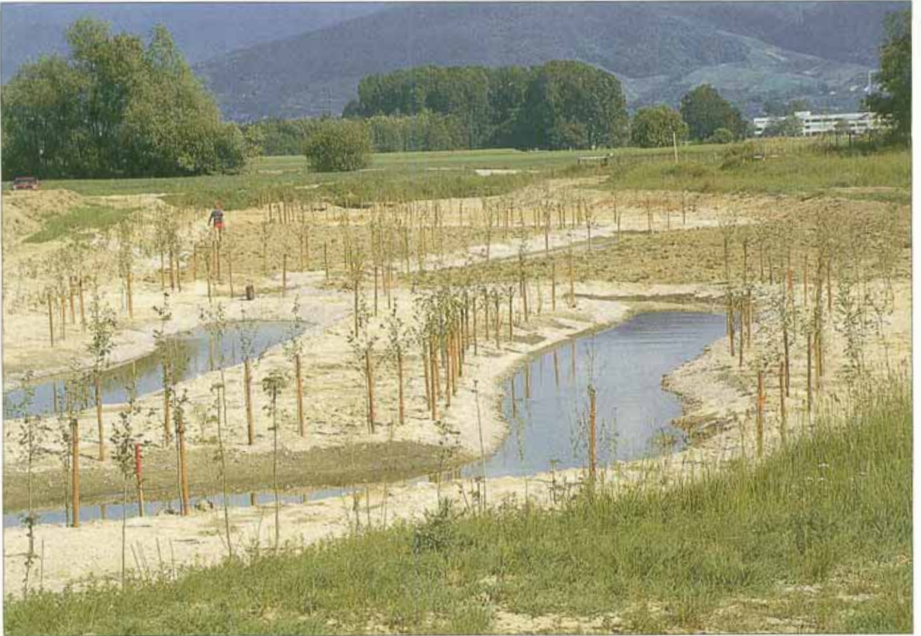
Im mittleren Bereich wurde ein unterstromig angeschlossener Altarm angelegt, der bei Entwicklung des oberhalb gelegenen Mäanders zum Hauptbett werden könnte (Scherle 5/90).
