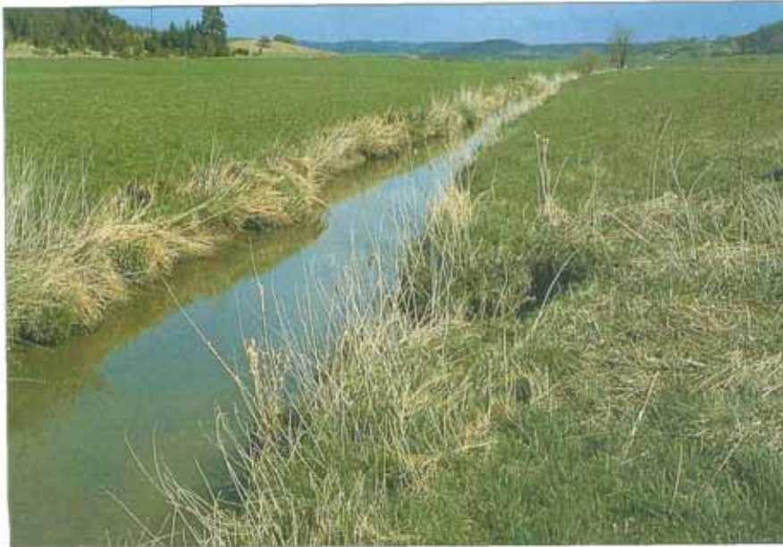
Die Kanalisierung in den Dreißiger Jahren hinterließ auf weiten Strecken ein gehölzfreies, nitrophytengesäumtes Gewässer, das mittlerweile leichte Uferabbrüche und Tendenzen zur Sohlenerosion zeigte (Horlacher 3/87).
