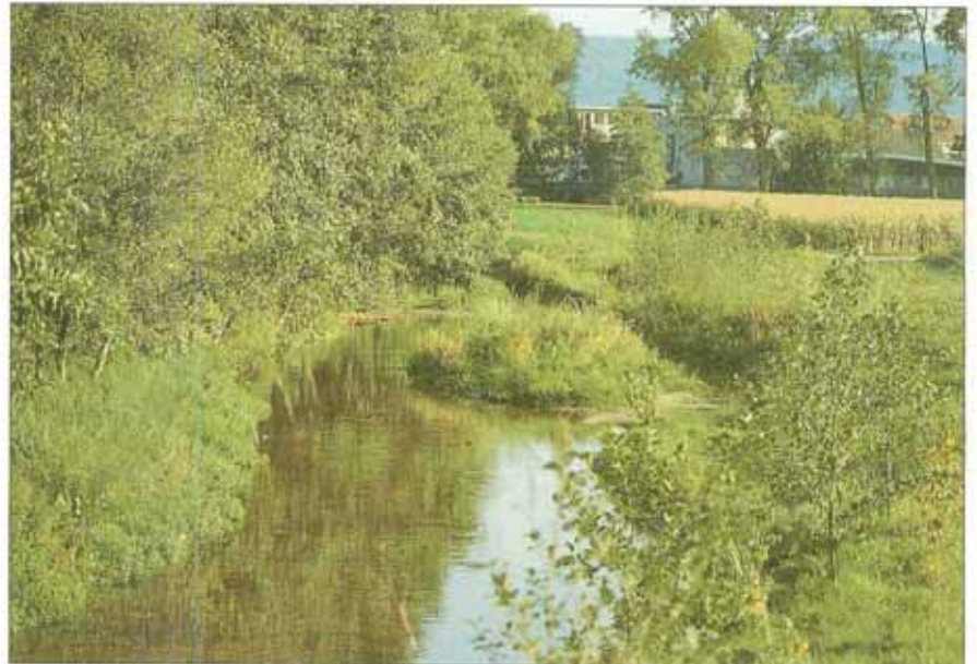
Ein Jahr später ist die Schottersicherung der Böschungsfüße vollständig zugewachsen und eine Pflanzung aus Erlen säumt das rechte Bachufer (Czerniak 7/88).
