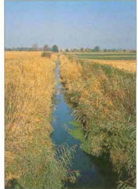
Das üppig sprießende Röhricht wächst ohne regelmäßige Mahd den Abflußquerschnitt weitgehend zu. Nur durch Anlage eines beschattenden Gehölzsaums könnten diese Unterhaltungseingriffe reduziert werden (Bostelmann 10/89).
