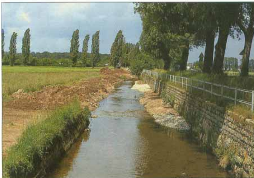
Im Rahmen der Baumaßnahmen wurde nicht nur die Buntsandsteinmauer mit einer Vorschüttung versehen, sondern auch das linke Bachufer mit einer flacheren Neigung und einem sich leicht schlängelnden Verlauf gestaltet (Czerniak 5/87).
