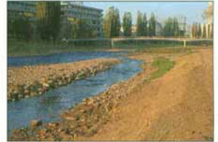
Höherliegende Uferpartien wurden abschnittsweise mit Kokos- und Jutematten abgedeckt (Bernhart 10/90).
