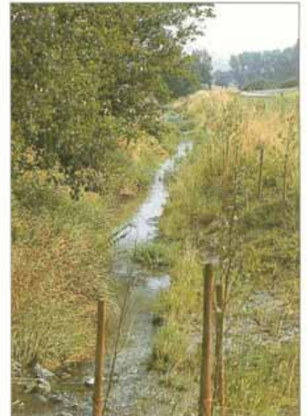
Nach der ersten Vegetationsperiode sind die hergestellten Böschungen bewachsen; die Gehölze haben noch keine Schattenwirkung (Czerniak 8/89).
