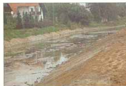
Überbreit aufgeweitetes Trapezprofil ohne Vorgabe eines Mittelwasserbetts kurz nach Fertigstellung (Scherle 8/90).
