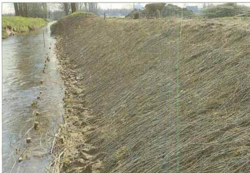
Anlagen einer Versuchsstrecke zur ingenieurbiologischen Ufersicherung: Die noch nicht übererdete Weidenspreitlage schützt die Böschungsfäche unmittelbar nach dem Einbau; am Böschungsfuß wurden Faschinenwalzen zur Sicherung eingebracht (Nadolny 4/87).
