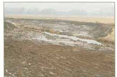
Soweit es die Gelände- und Eigentumsverhältnisse zuließen, wurde wechselseitig abgegraben, um an beiden Ufern aueähnliche Standortbedingungen zu schaffen (Humborg 2/91).
