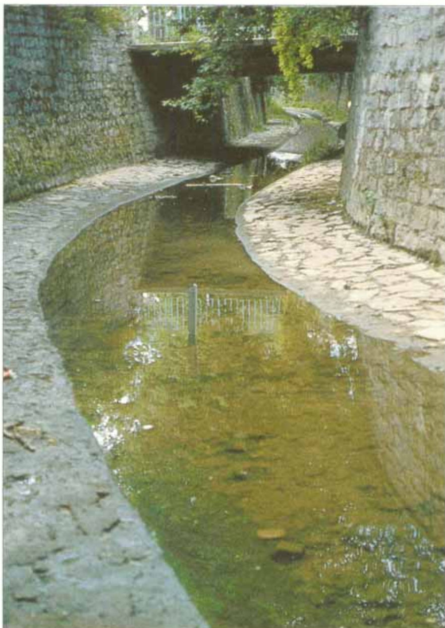
Harter Ausbauabschnitt der Glems im Siedlungsbereich (All).
