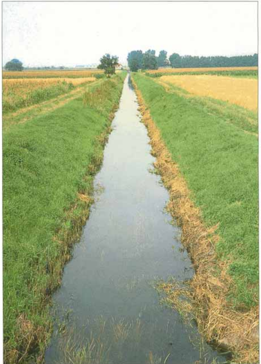
Schnurgerade Linienführung, ein einheitliches Trapezprofil und das fast vollständige Fehlen von Gehölzen charakterisieren den Kehrgraben nahezu auf ganzer Länge im Untersuchungsgebiet. Bei den Unterhaltungsarbeiten ist auf der linken Böschung eine Strecke von der Mahd ausgenommen worden (Bostelmann 8/87).
