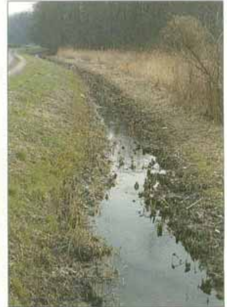
Freigemahte Strecke am Alten Federbach (vgl. S. 38/39) mit mächtigen Schlammablagerungen (Nadolny).
