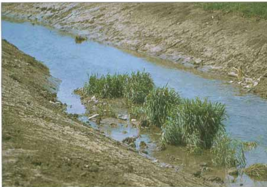
In kleinen Aufweitungen wurden mit Röhrichtinseln amphibische Zonen geschaffen (Horlacher 8/89).
