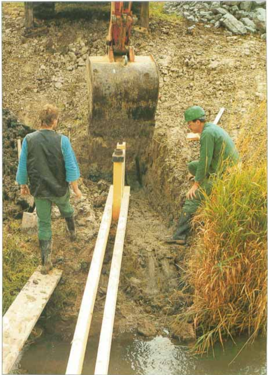
Auf dem größten Teil der Strecke wurde das Bett unter Schonung des vorhandenen Bewuchses aufgeweitet und die Böschungen abgeflacht (Kern 8/88).
