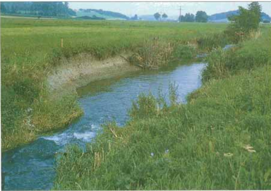
Zur Sohlssicherung in großen Abständen eingebaute Abstürze sind verfallen und führten zu ausgedehnten Kolken, die als Geschiebefallen wirken (Horlacher 5/87).
