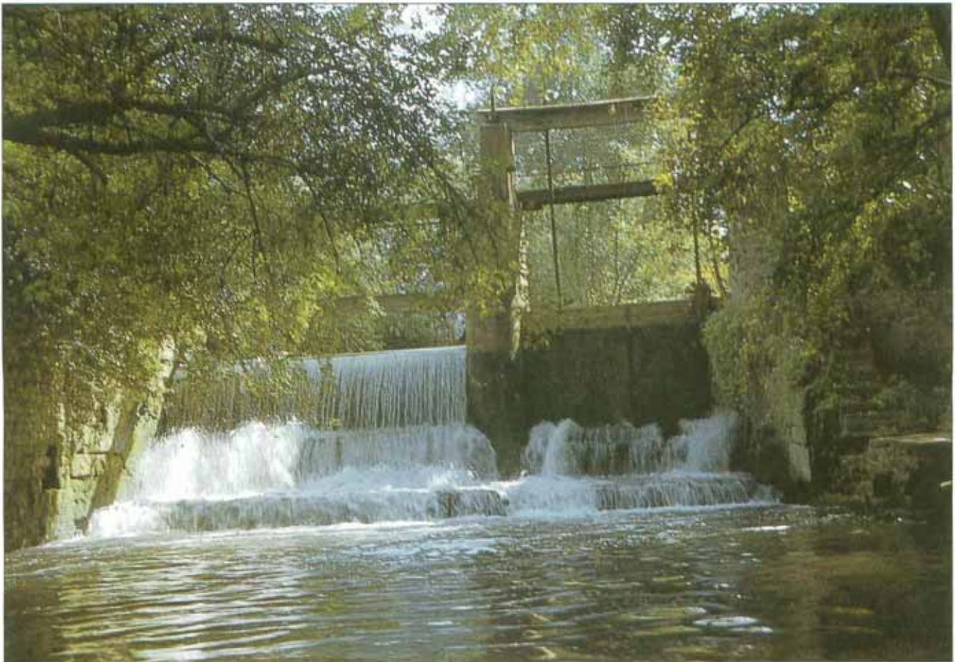
Alte Wehranlage mit fester Schwelle und Schütztafel (Mayer-Peters).
