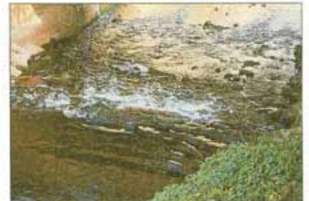
Die neu geschüttete Sohlenrampe am Ende der Projektstrecke erleichtert den Aufstieg von Organismen aus der Enz (Schade 12/89).
