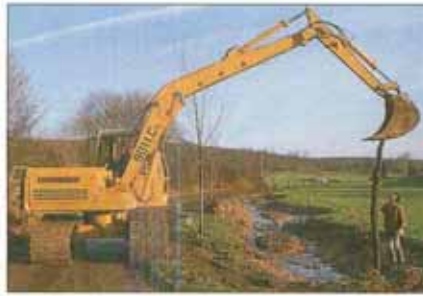
Beim Eindrücken der Weidenäste sind große Stammstücken vorteilhaft; da sie mehr eigenen Saft gespeichert haben, kommt es auch zu geringeren Ausfällen (Wolf 12/88).
