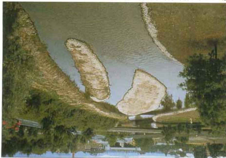
Die umgestaltete Alb in gleicher Perspektive wie oben links. Mit Inseln und geschwungener Uferlinie werden Elemente der ursprünglichen Flusslandschaft nachgebildet. Die Beschleunigungsstufe wird auch mit Kiesstrukturen gesichert. Deutlich wird auch die Einschnürung der Alb durch zahlreiche querende und begleitende Straßen (Weitz 5/88).
