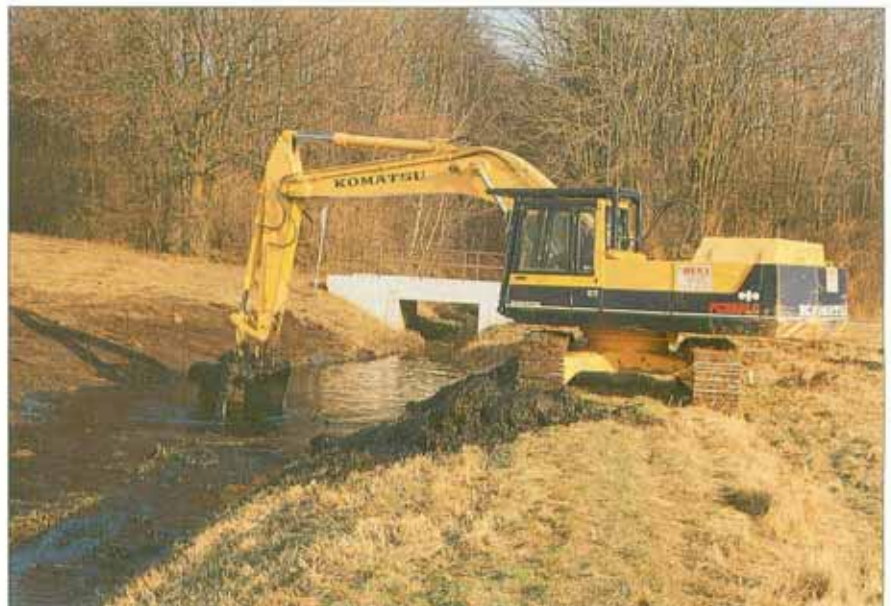
Herstellung eines Schlammfangs am Beginn der Umgestaltung (Humborg 2/91).
