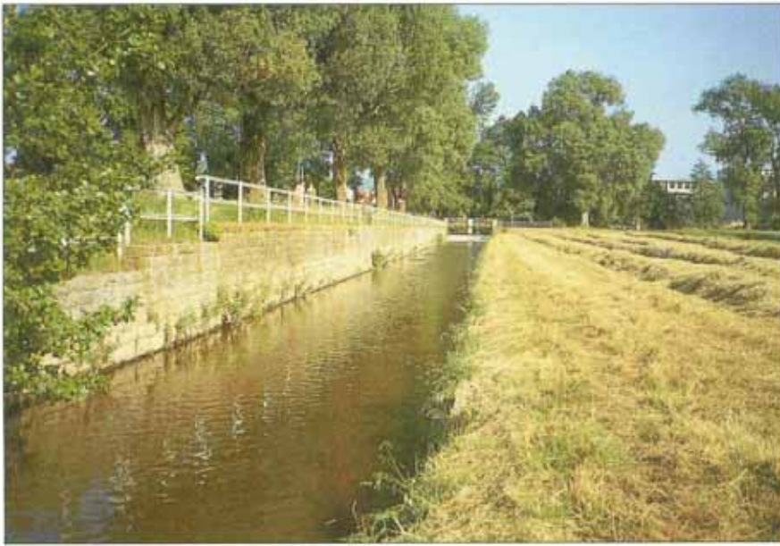
Vor der Umgestaltungsmaßnahme am Reiherbach wurde das rechte Bachufer streckenweise durch eine kahle Buntsandsteinmauer gebildet (Thiess 7/86).
