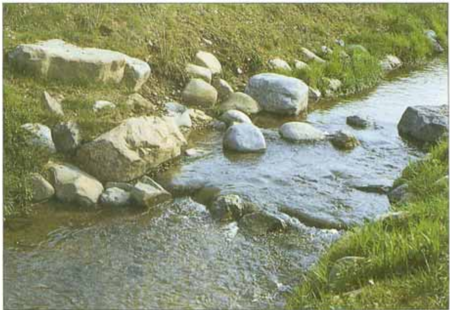
Steinriegel bilden kleine Querwerke, die bei Mittelwasser eine Gliederung in Schnellen und Stillen hervorrufen (Kern 4/91).
