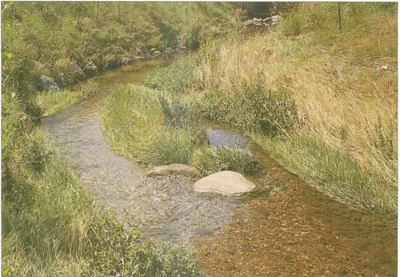
Die Sohlenpflasterung ist durch eine Kiesauflage ersetzt worden, die bei größeren Abflüssen auch in Bewegung gerät. Im Strömungsschatten von Störsteinen konnten sich daher kleine Inseln bilden, deren Bewuchs die Standortvielfalt erhöht (Gebler 7/89).
