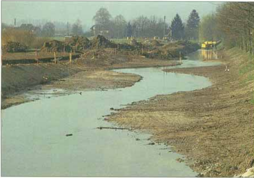
Auf einer 550 m langen Strecke wurde das Bett auf das Doppelte aufgeweitet und ein flaches, geschwungenes Mittelwasserbett angelegt. Die entstandenen Bermen liegen nur knapp über Mittelwasserniveau (Scherle 2/90).
