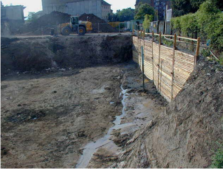
Abbildung 27: Bodensanierung auf dem Epple-Areal (Juli 2002)
