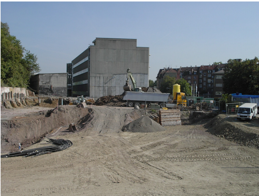
Abbildung 28: Bodensanierung und Wiederauffüllung auf dem Epple-Areal (September 2002)
