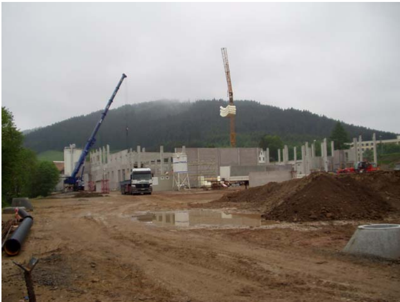
Abbildung 35: Baureifmachung und Neubau auf dem Okal-Areal (Frühjahr 2003)
