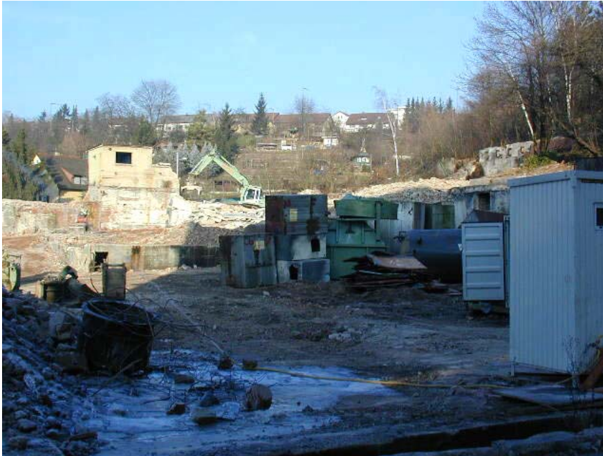
Abbildung 23: Rückbau der Gebäude auf dem Epple-Areal (Januar 2001)
