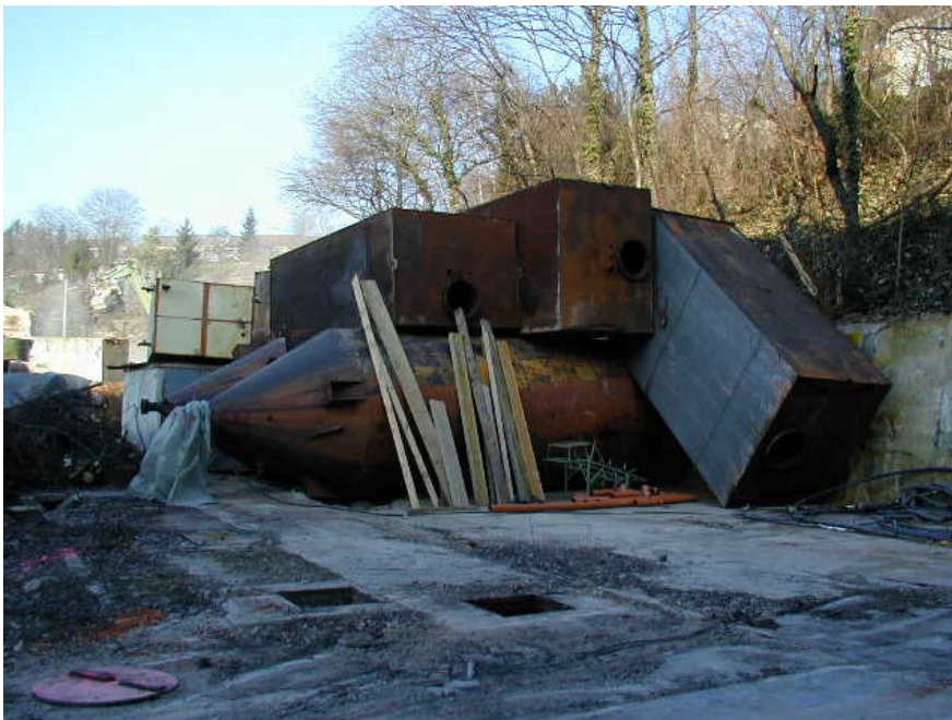
Abbildung 24: Rückbau der Gebäude und Abfallentsorgung auf dem Epple-Areal (Januar 2001)
