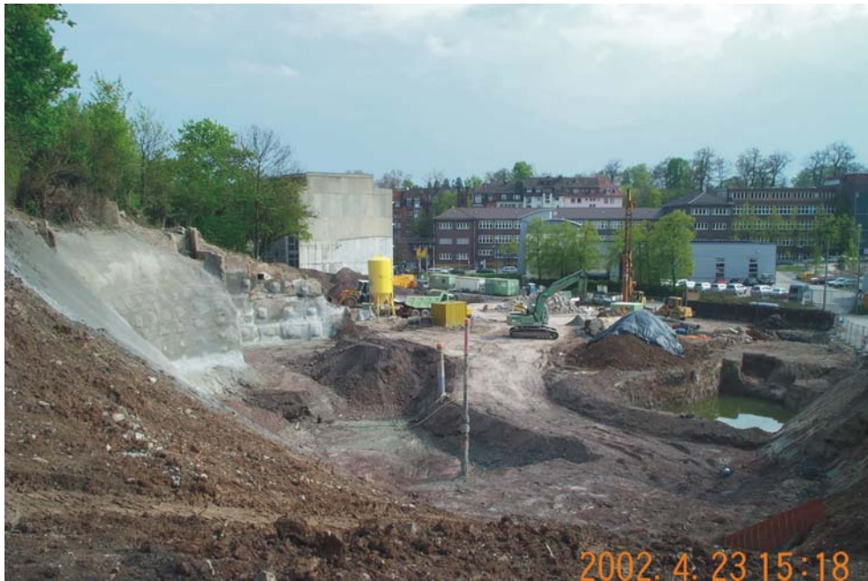
Abbildung 25: Bodensanierung auf dem Epple-Areal (April 2002) (AFU 2002)
