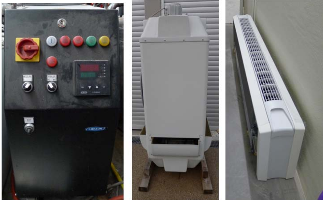
Abbildung 60: elek. Heizung (links), Kühlturm (Mitte), Fan coils (rechts)
