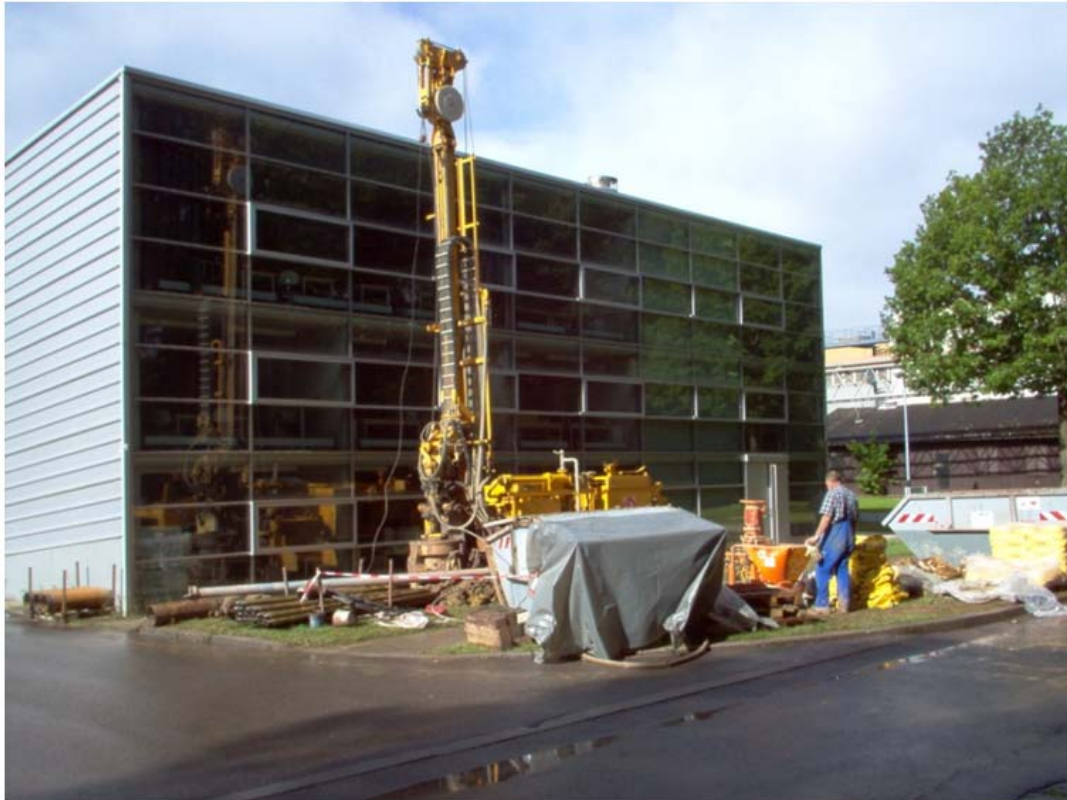
Abbildung 57: Bohrarbeiten zur Herstellung der Erdwärmesonden
