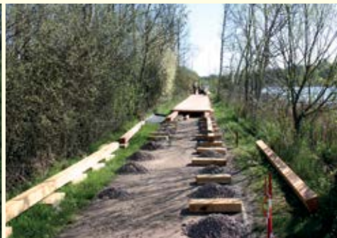
Ein Steg entsteht: Die Erhöhung des Rundwegs ermöglicht es, trotz der Wiedervernässung trockenen Fußes das Moos besuchen zu können.
