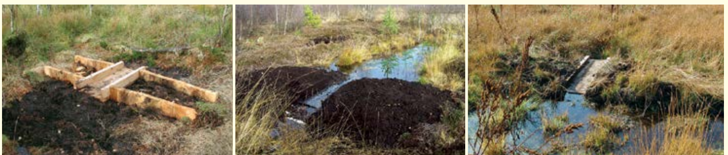
Doppelwandige Sperre mit Torfen verfüllt und überdeckt, nach zwei Jahren eingewachsen.
