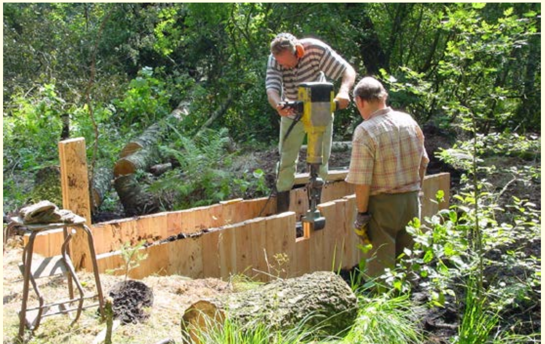
Die Lärchenholzbohlen können relativ einfach mit einem Elektro-Schlaghammer in die Torfe getrieben werden.
