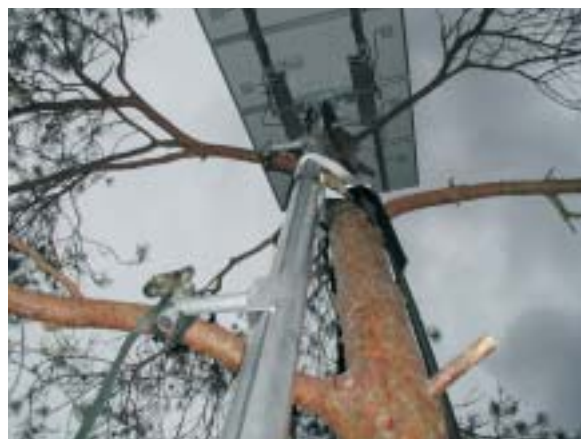
Abbildung 5.1-2 Zweite Solar-Baummontage an der Messstelle Forst
