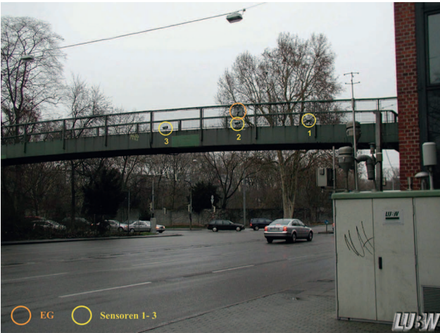
Fahrtrichtung Bad Cannstatt (Fußgängerbrücke)
