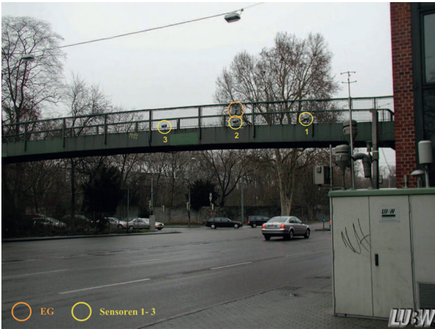
Fahrtrichtung Bad Cannstatt (Fußgängerbrücke)
