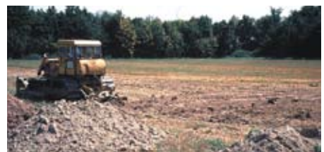
Flache Geländeauffüllung (20 cm)
