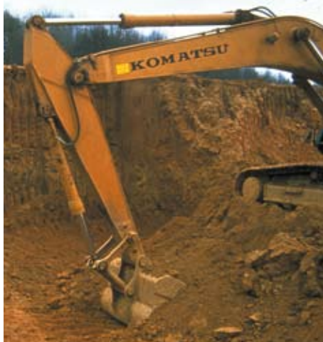
Ausbau mit Hydraulikbagger
