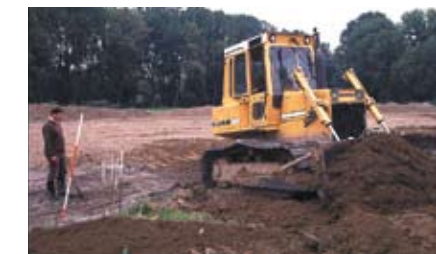
Überwachung einer Geländeauffüllung
