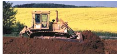
Profilieren einer Bodenmiete
