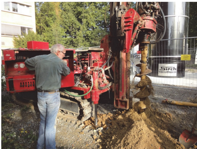
Abbildung 3.1: Installation einer Helix-Sonde am ITW
