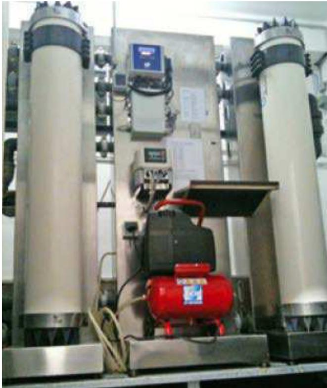
**Bild 23:** IN-OUT-Filtrationsanlage der Firma Seccua GmbH (Foto: Büntig, Y.)
