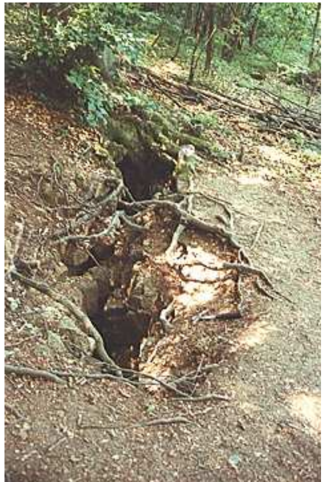
Abb. 117: Hangabrissschlüfte im Bietigheimer Forst (Nr. 3. ND).
