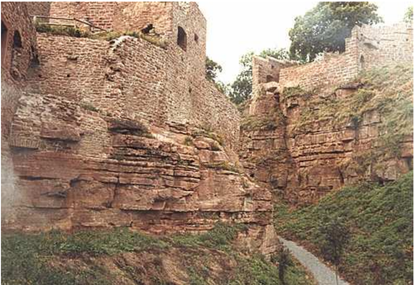
Abb. 19: Aufschluss des Hauptbuntsandsteins (sm) im Ringgraben der Burg Wertheim. (Nr. 2 der zur Unterschutzstellung vorgeschlagenen Objekte). Hier harmonisieren Bebauung und Erhaltung eines Aufschlusses.
